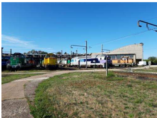
Photo n°1 : rotonde de maintenance d'automoteurs diesels
