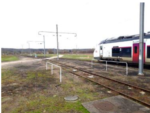
Photographie 5 : Remblais apparent sur terrain nu à l'est du site
