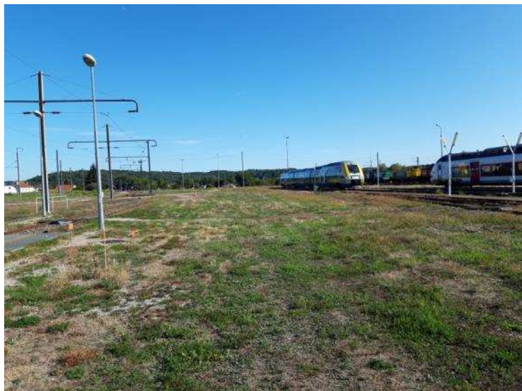
Photo n°2 : voies de remisage et de stationnement
