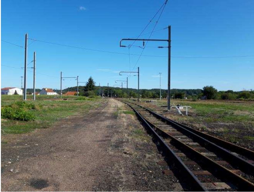
Photo n°6 : voies au nord du site
