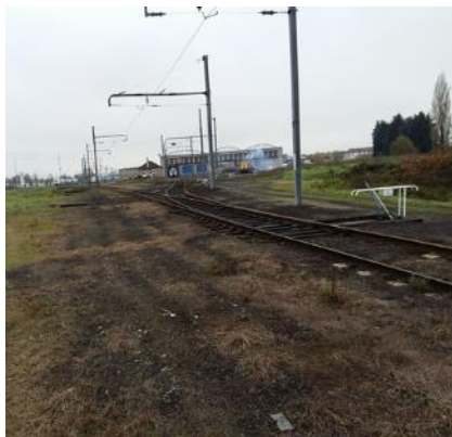
Photographie 11 : Vue vers le nord du site
