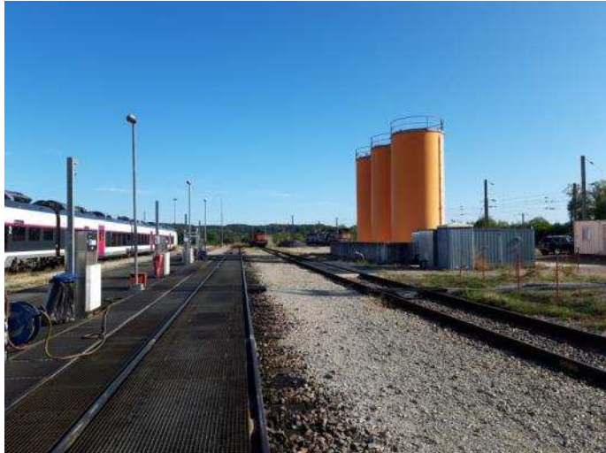
Photo n°4 : station-service et cuves de stockage de gasoil
