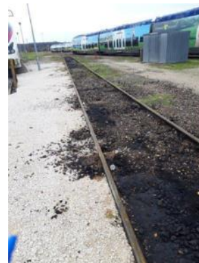
Photographie 4 : Remblais souillés sur les voies de stationnement
