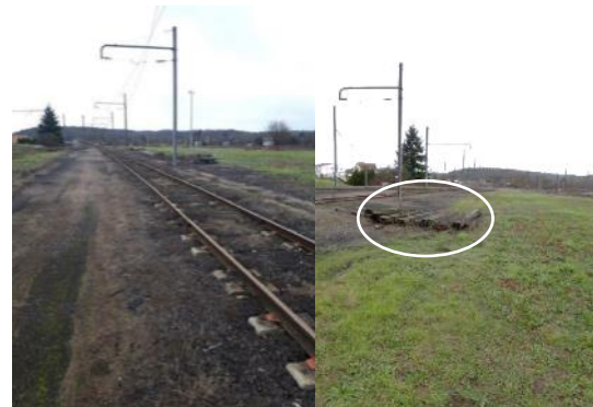
Photographie 6 : Remblais et stockage d'éléments métalliques et de traverses sur terrain nu
