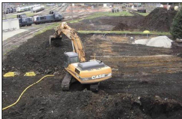
FIGURE 17 : PHOTOGRAPHIE DE LA MISE EN PLACE DU BIOTIERRE AU SUD-EST DE LA ROTONDE (SOURCE : RAPPORT VEOLIA, JUIN 2011)
