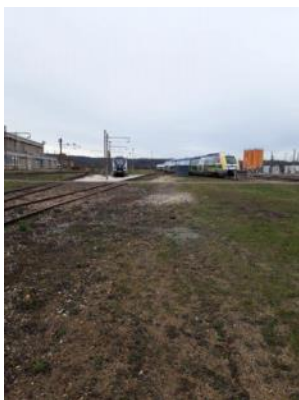
Photographie 3 : Remblais apparent sur terrain nu au sud du site
