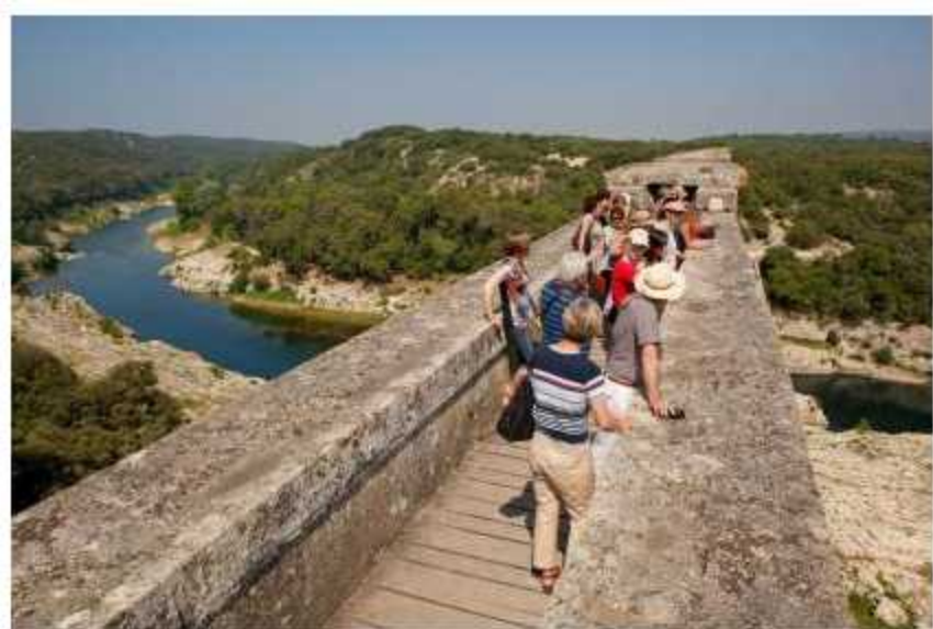
Vue depuis la canalisation au 3ème étage du Pont (Yann de Fareins)
