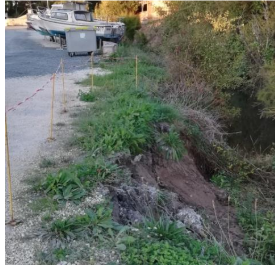
Erosion des berges du Riveau
