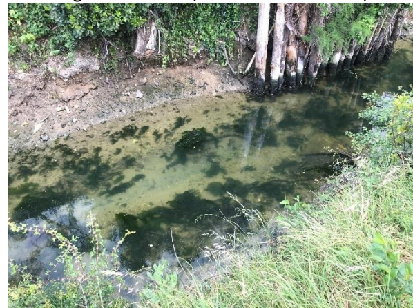
Fond du Riveau au niveau du confortement
