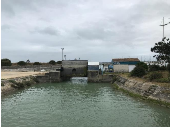
Ecluse de la Maison (Chenal du Douhet)
