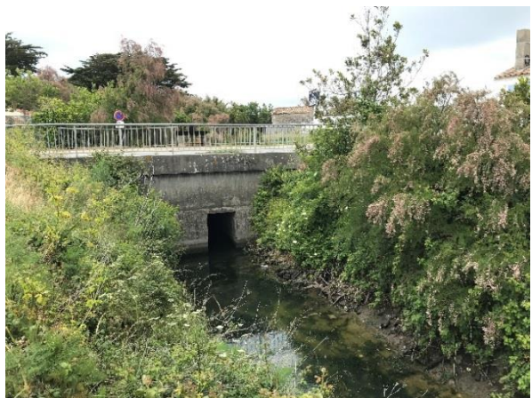
Cadre au niveau du Pont de la route de la Forêt
