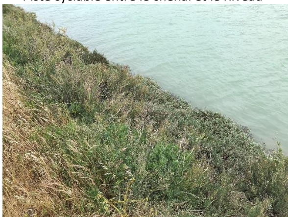
Berge du Chenal au niveau de la station de pompage
