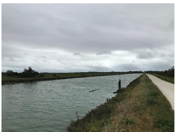
Ecluse de prise d'eau de la Ferme Marine
