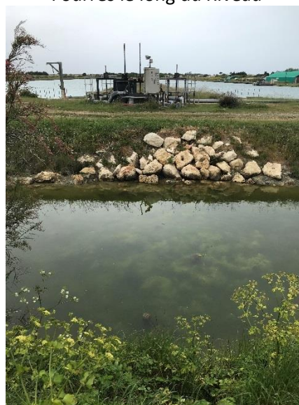
Riveau au niveau de la station de pompage
