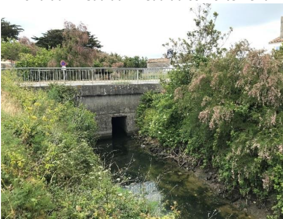
Cadre au niveau du Pont de la route de la Forêt
