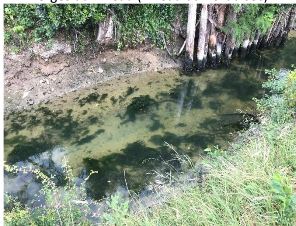
Fond du Riveau au niveau du confortement
