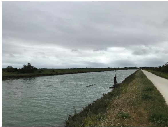
Ecluse de la prise d'eau de la ferme du Douhet
