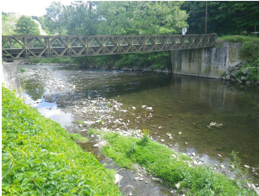
Figure 19 : Pont du hameau de la Fléchette
