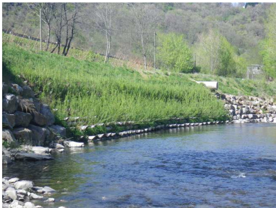
Figure 17 : Ouvrage de génie végétal (caissons végétalisés) - photo avril 2014
