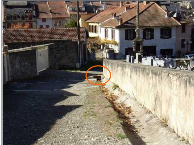
*Figure 3.22: cunette en béton aménagée parallèlement au cimetière. En arrière plan on distingue l'entrée de la buse traversant le bourg et sa grille de protection.*
