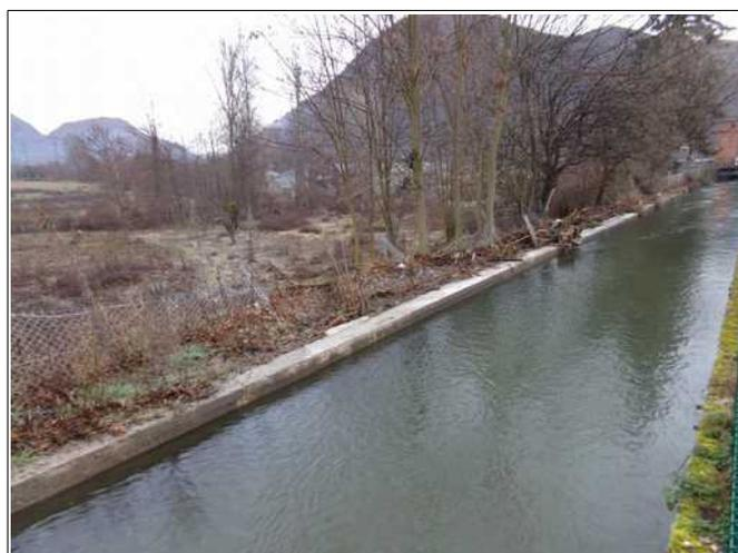
*Figure 3.19: canal du torrent de la Courbière et traces de débordements observées en janvier 2018.*
