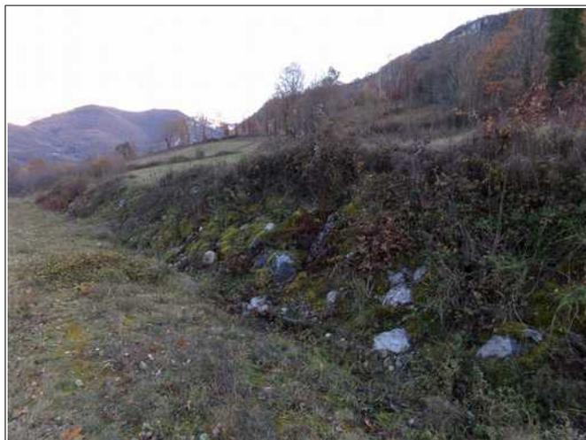
*Figure 3.31: talus amont de la RD23 enroché au droit de la zone industrielle du Fournié. On notera la faible pente générale du terrain.*
