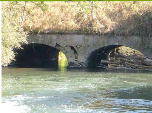
Vue sur le pont depuis la rive droite amont de l'Oise, avec zoom sur une cavité dans la pile
