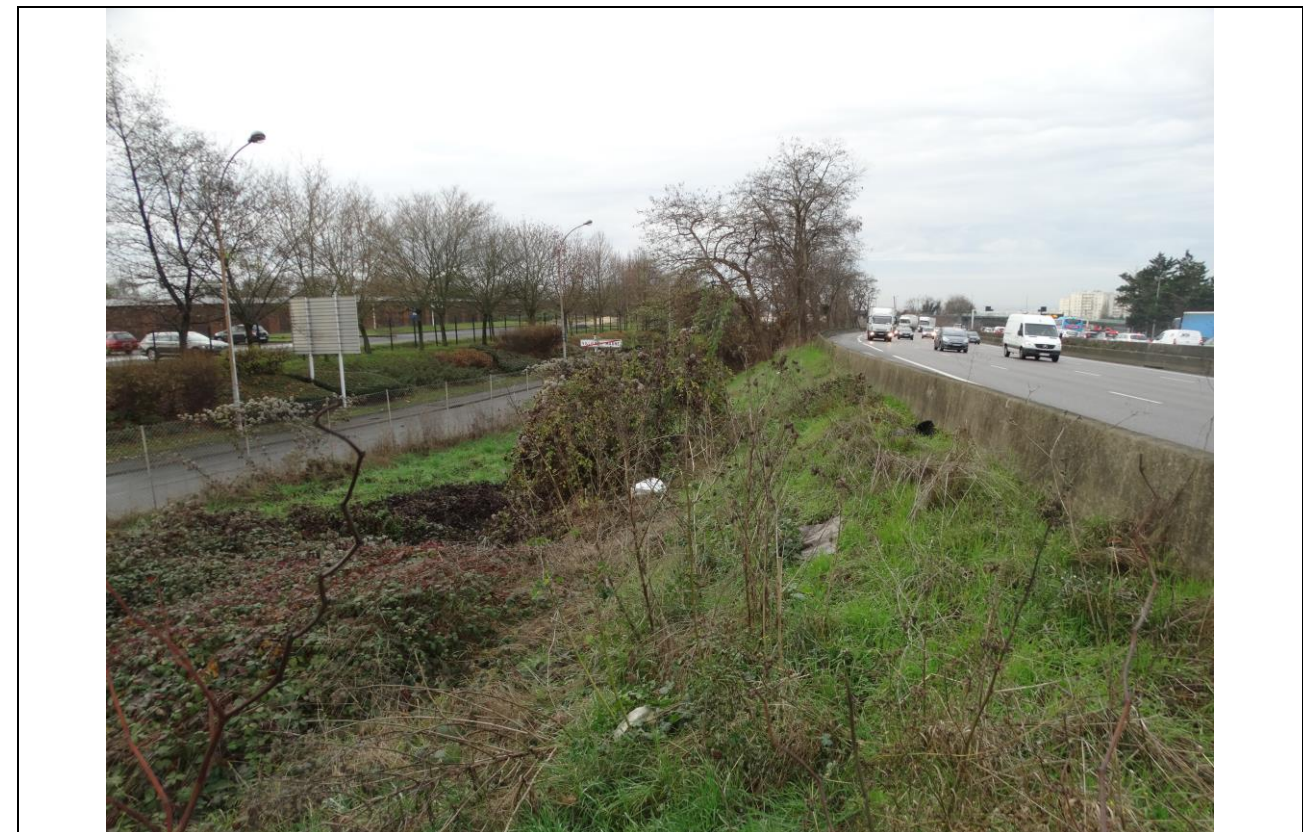
1 - Vue de l'A4 et de la RD11 depuis le point d'arrivée de la bretelle d'accès - Vue vers l'Ouest dans l'axe de la bretelle - BURGEAP 13/12/2016
