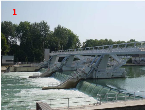
Barrage à clapets de Vives-Eaux, vue depuis l'aval en rive gauche (Photo prise le 25/07/2018)
