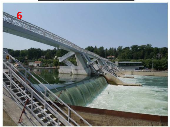
Clapet droit du barrage de Vives-Eaux, vue depuis l'aval en rive droite (Photo prise le 25/07/2018)
