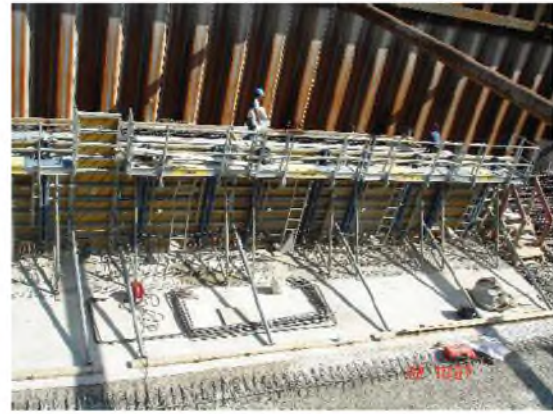
Bétonnage radier de barrage et : Coffrage 1 face contre palplanche (Source : CHARIER TP)
