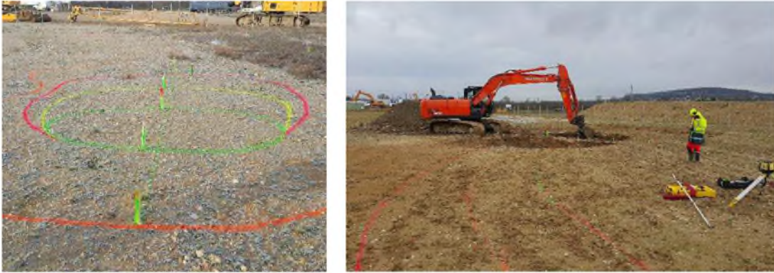
Implantation et piquetage (Source : Entreprise CHARIER TP)
