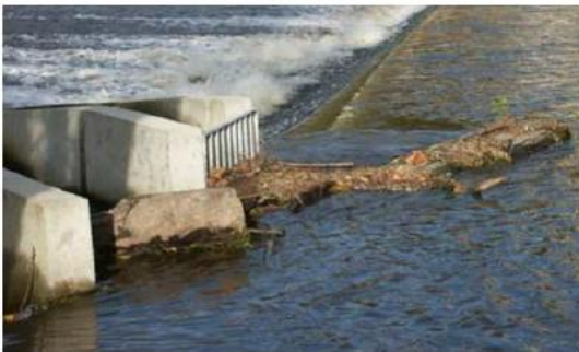
Photo de l'encombrement d'une entrée hydraulique
