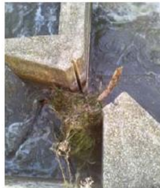
Photo de l'encombrement d'une échancrure interbassin
