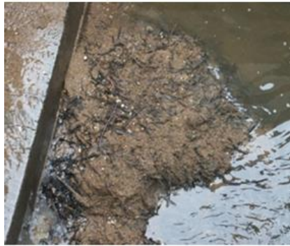
Photo de l'engravement d'une passe à bassins
