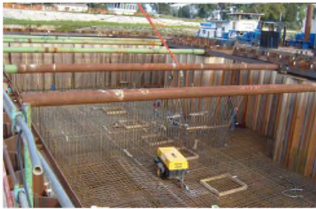
Bétonnage radier de barrage et : Coffrage 1 face contre palplanche (Source : CHARIER TP)
