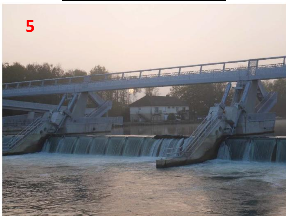
Clapet central du barrage de Vives-Eaux, vue depuis une pile du barrage (Photo prise le 18/10/2018)
