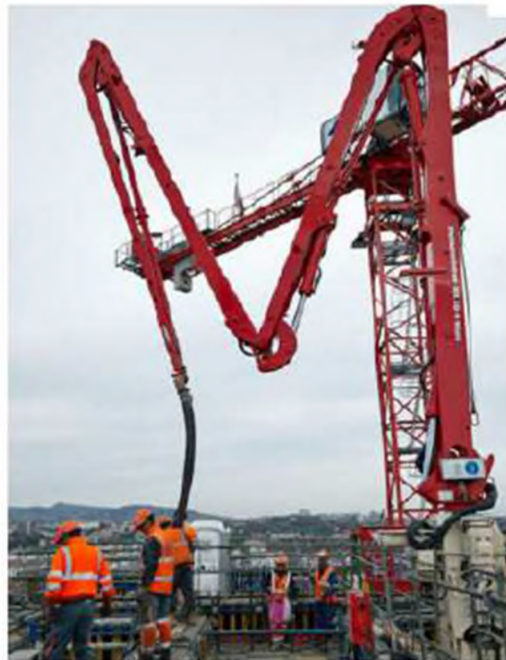
Mât de bétonnage (CHARIER TP)
