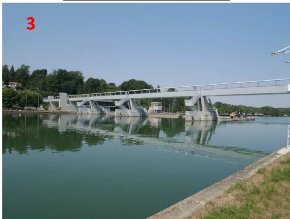
Barrage à clapets de Vives-Eaux, vue depuis l'amont en rive droite (Photo prise le 25/07/2018)
