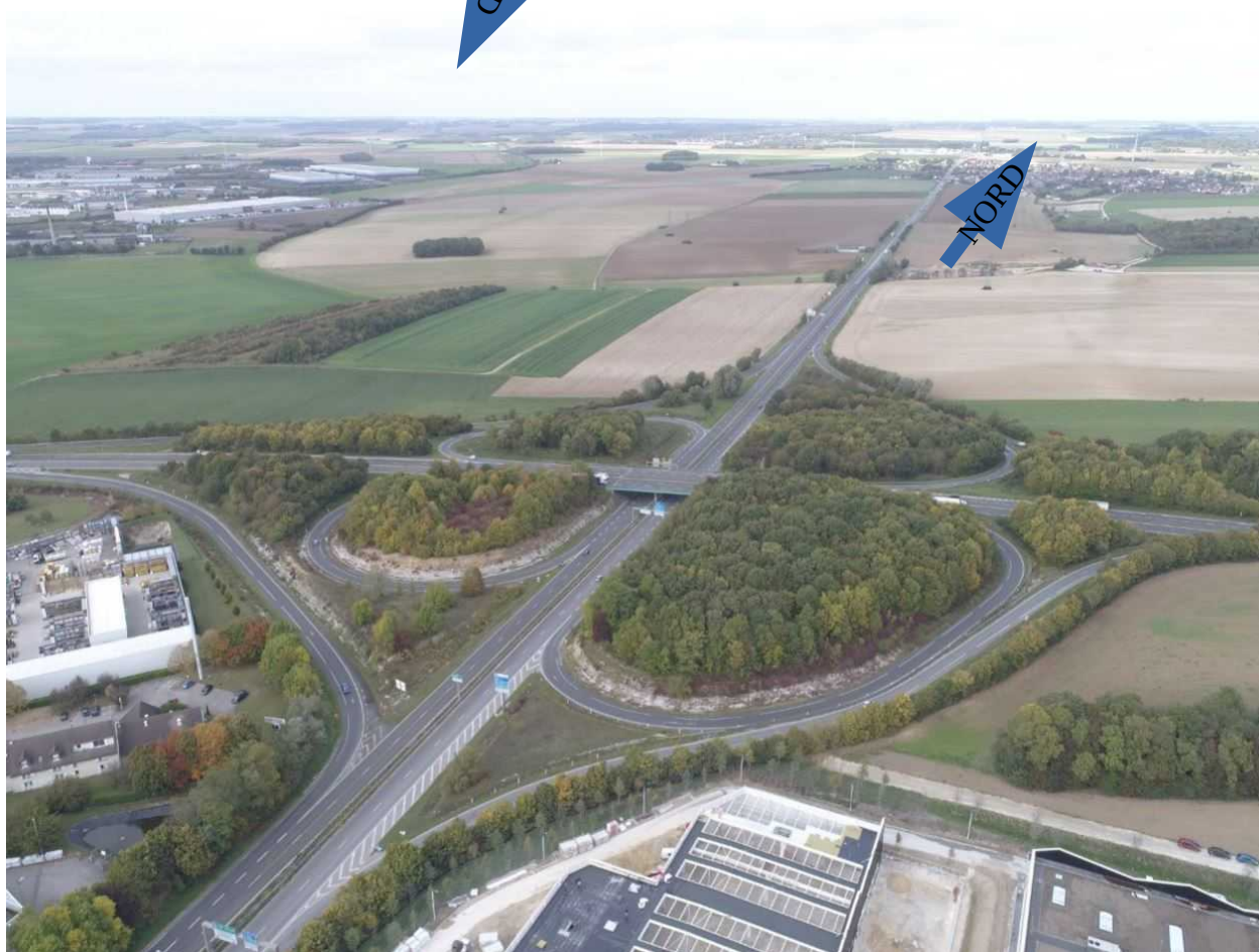
Vue aérienne en direction de Poulainville
