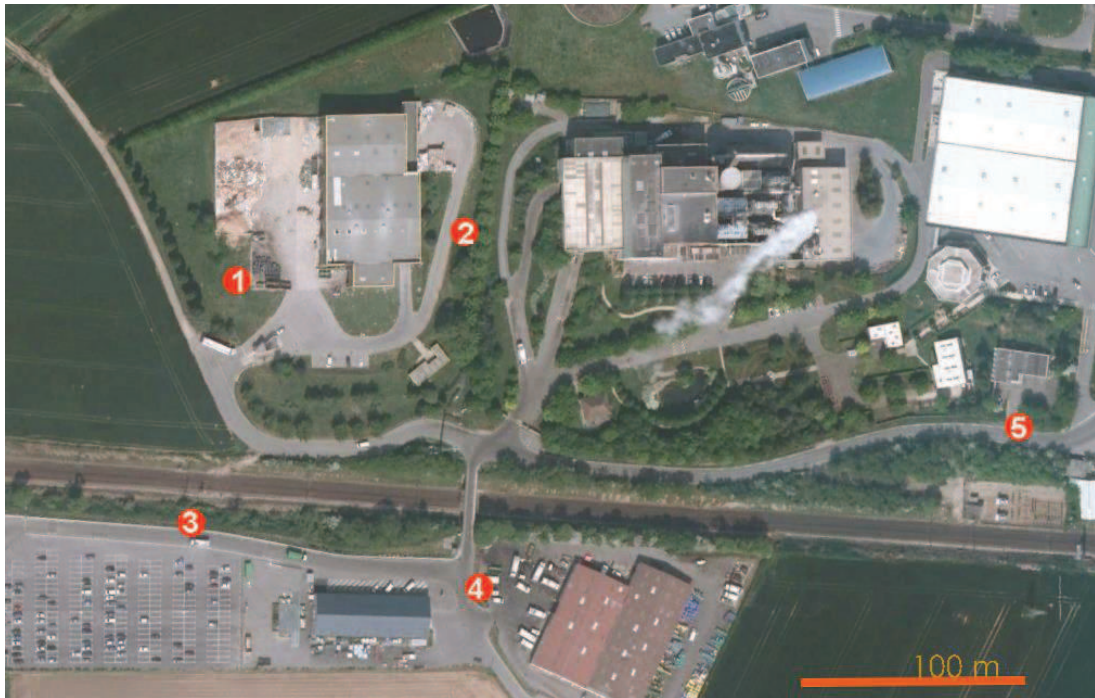
Figure 2. 5 poteaux incendie, dont 2 sur site
