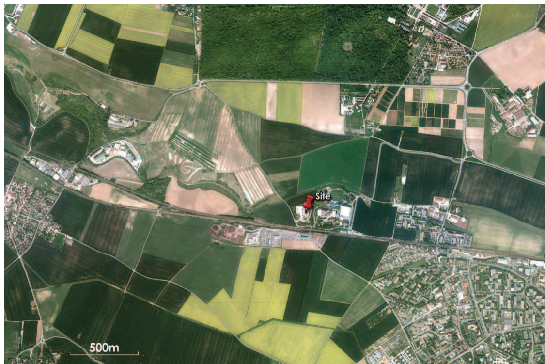
Figure 94. vue aérienne du site et de ses abords
