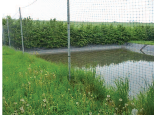
Figure 39. Bassin de tamponnage
