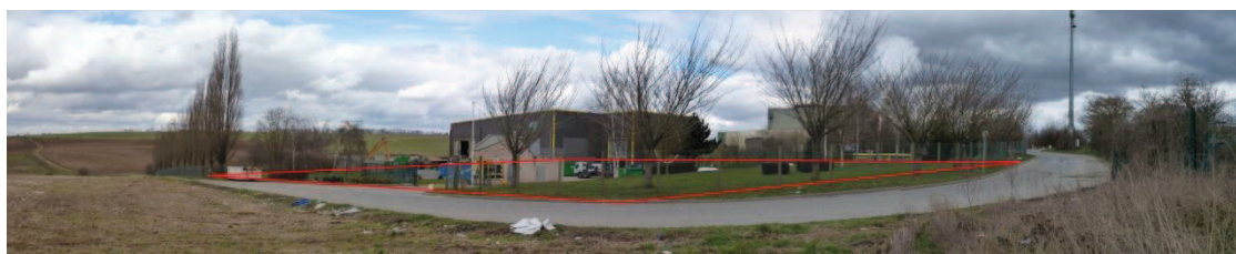
Figure 28. Accès au centre de tri
