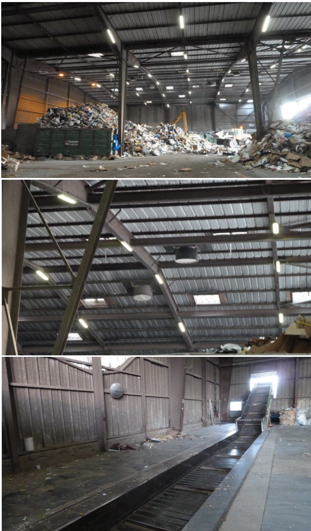
Figure 33. Bâtiment de tri
