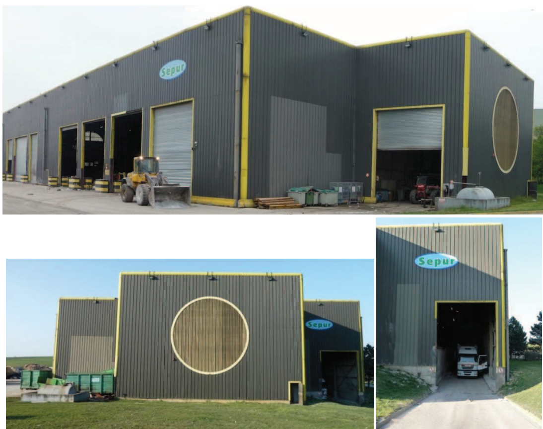
Figure 32. Photographies du bâtiment de tri et transit
