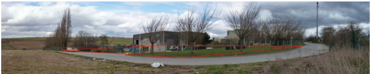
Route d'accès au centre de tri
