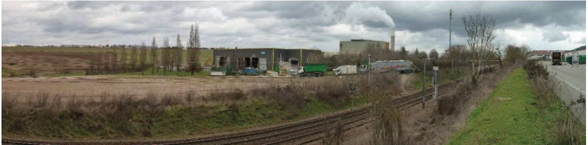
Figure 104. Vue Sud des abords du site
