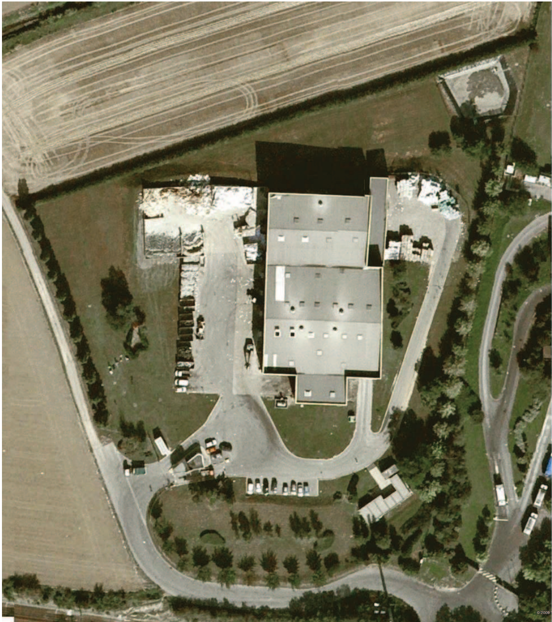
Figure 25. Vue aérienne centre de tri SEPUR Thiverval - 2011
