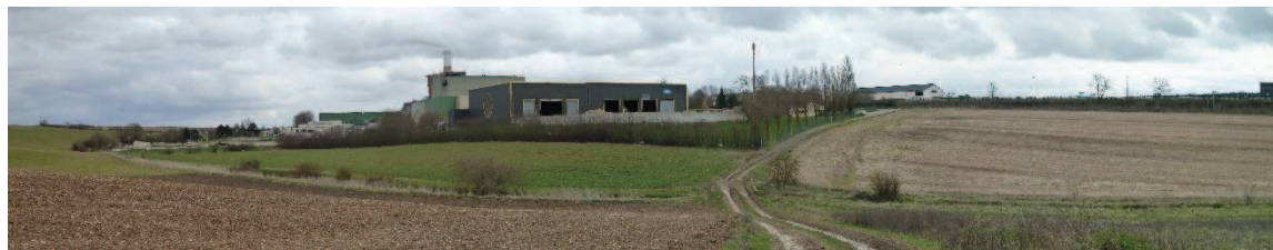
Figure 84. Vue panoramique depuis l'entrée de la plateforme du BTP au Nord du site
