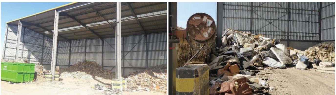
RIA 1 -- en limite du hangar écomobilier
