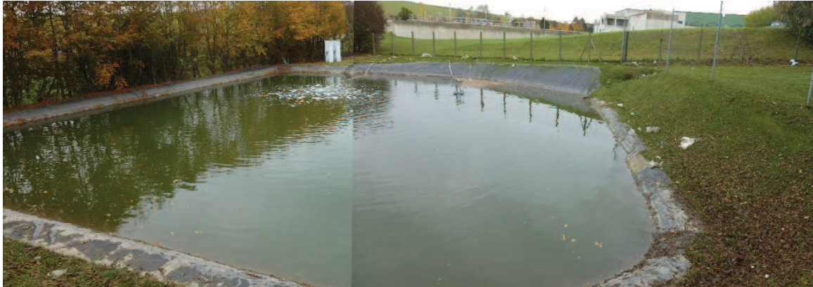
Figure 7. Bassin de tamponnage
