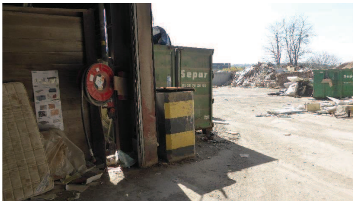
RIA 2 - en limite du hangar écomobilier
