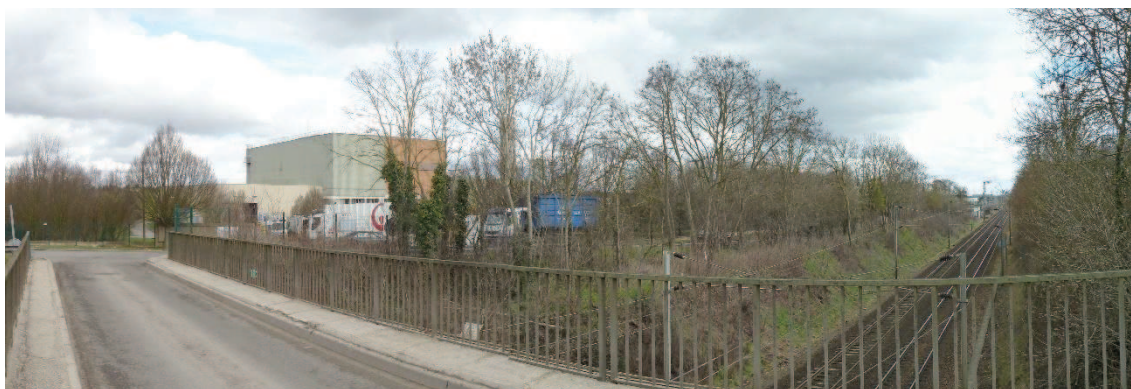
Figure 102. Vue Sud des abords du site.
