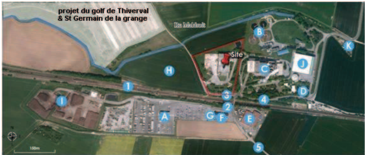
Figure 57. Abords du centre de tri
