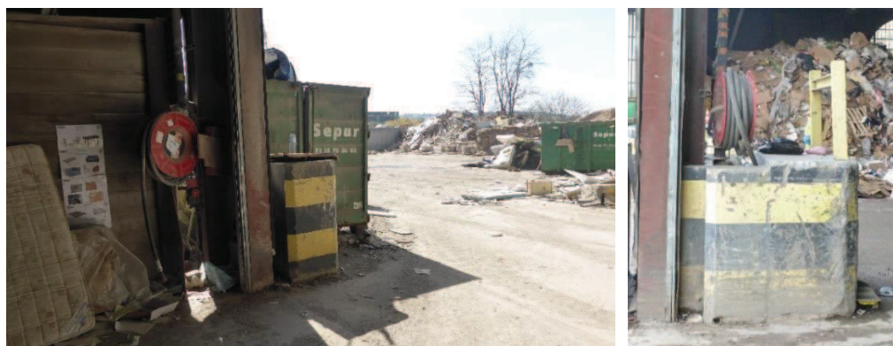
RIA 2 - en limite du hangar écomobilier
