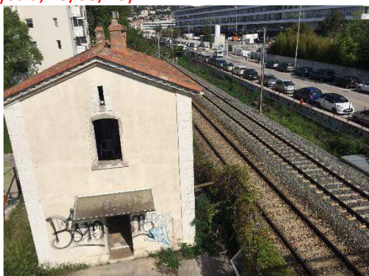
3 : vue de l'ancienne maison garde-barrière depuis la passerelle ville-ville (Systra, 19/04/18)
