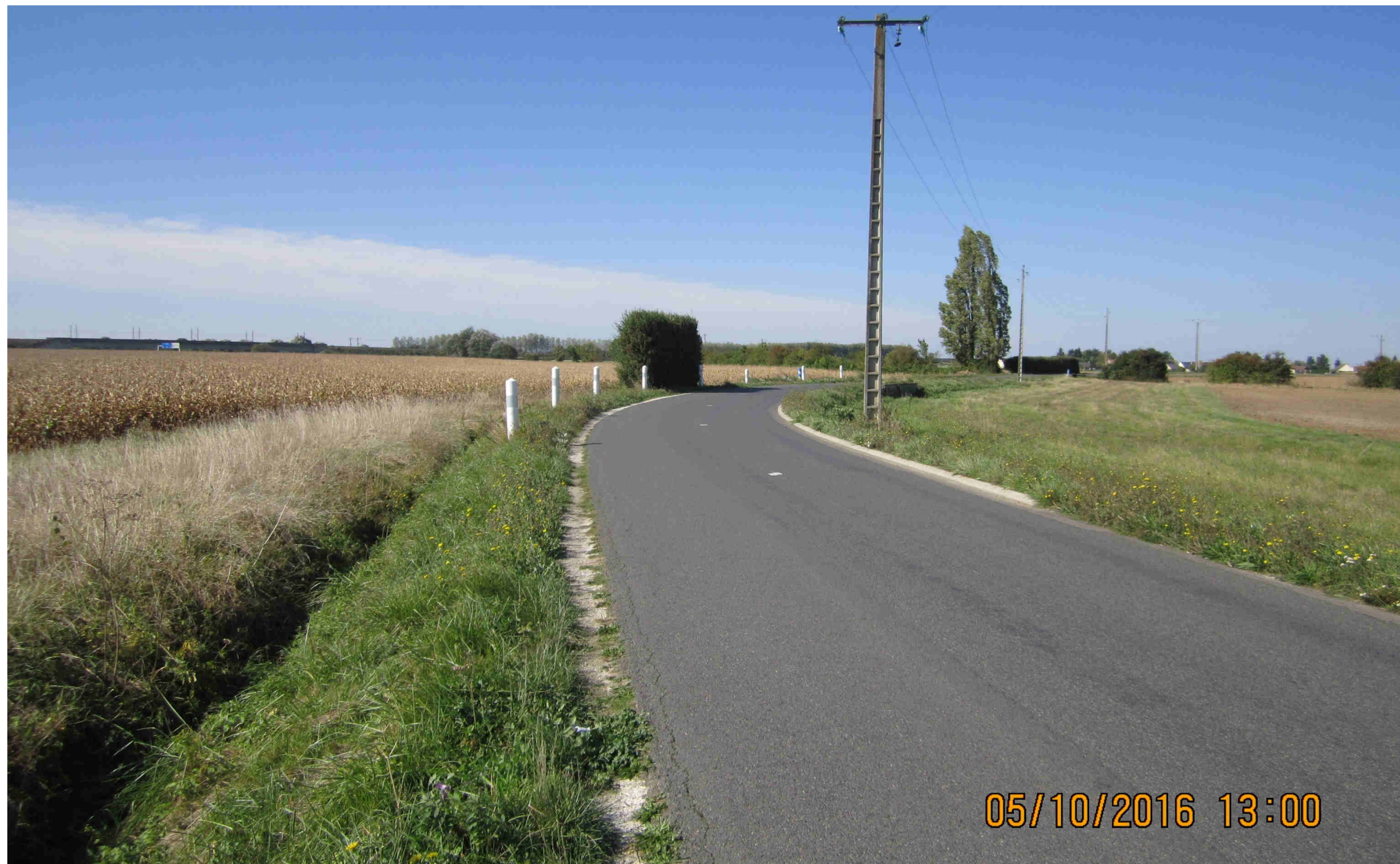
Photo n°3 – Situation du site dans un environnement proche – Tronçon de la RD57 à recalibre
