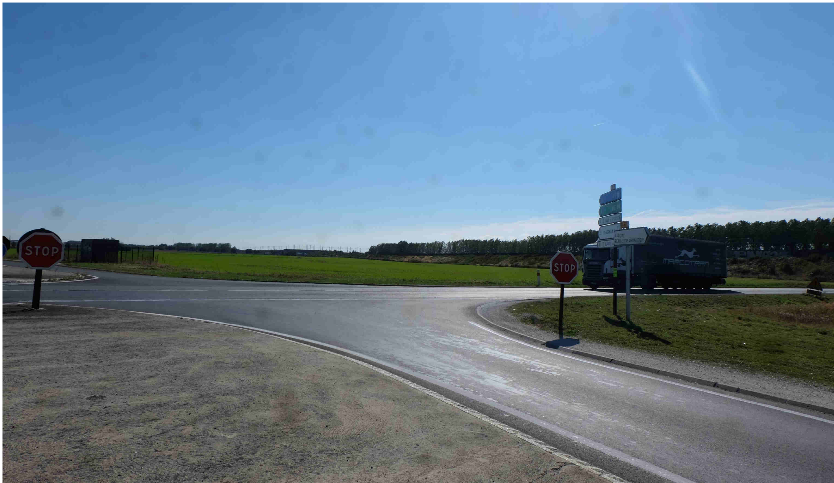
Photo n°10 – Situation du site dans un environnement proche – carrefour plan RN36-RD57 à transformer en carrefour giratoire à 5 branches
