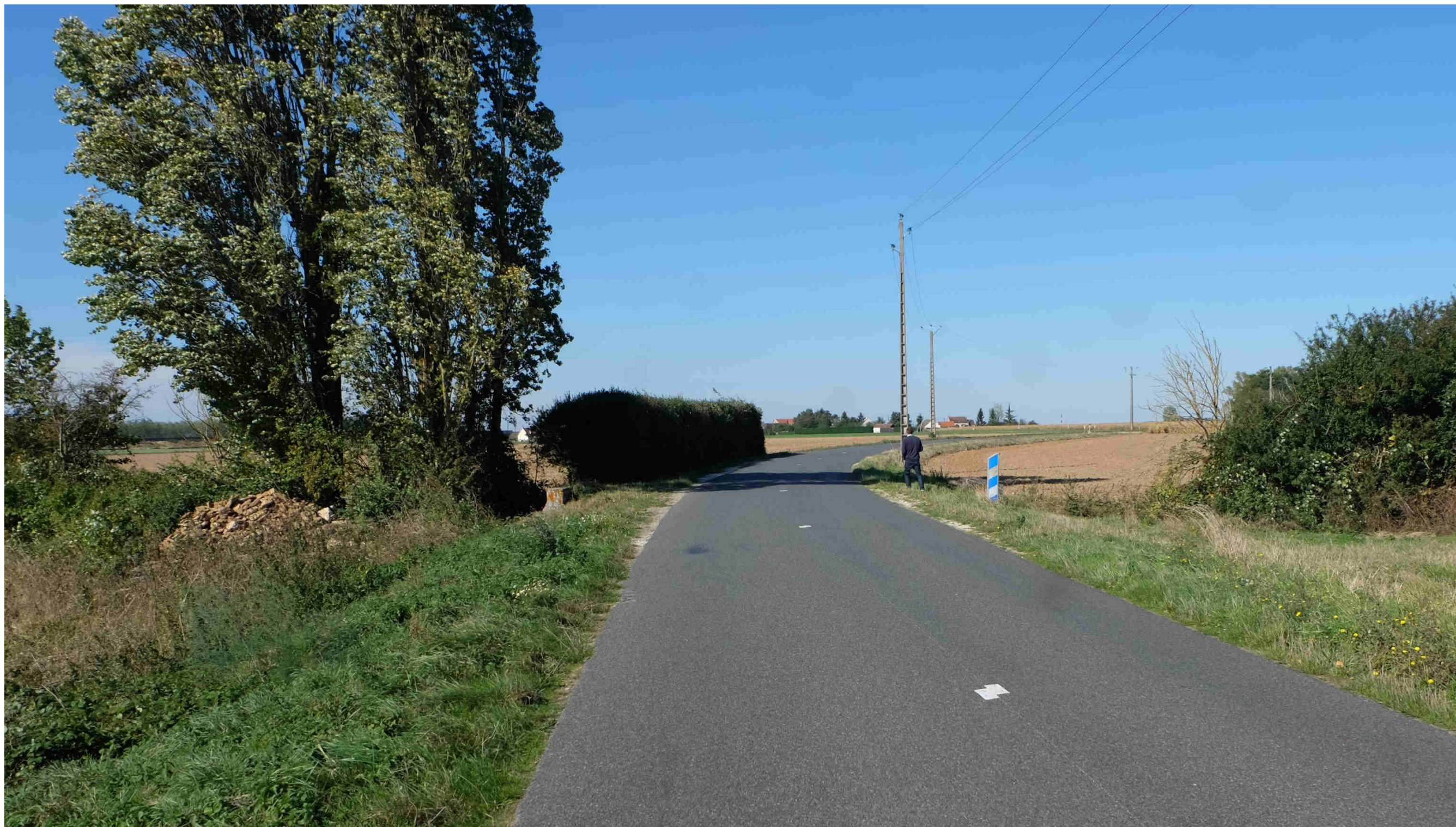
Photo n°5 – Situation du site dans un environnement proche – Ouvrage enjambant le Ru d'Andy conservé en l'état
