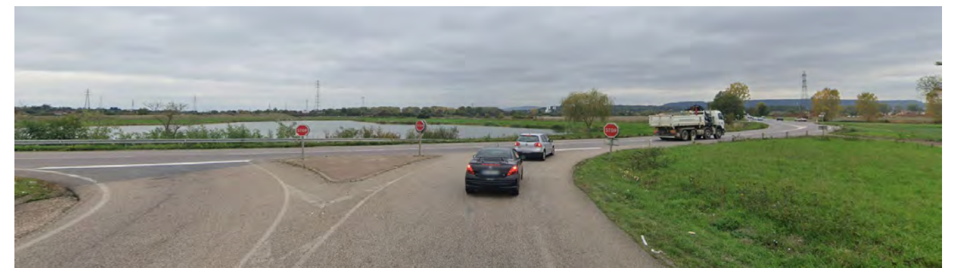
Photographie 2 : Carrefour A31/RD60 existant (source : Street View, octobre 2020)
