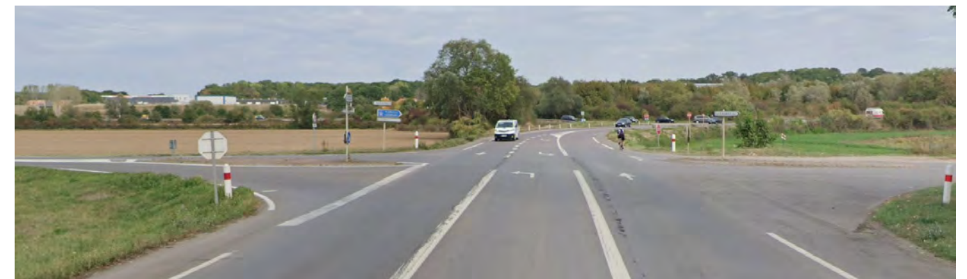
Photographie 1 : Carrefour RD60/RD61 existant (source : Street View, septembre 2019)
