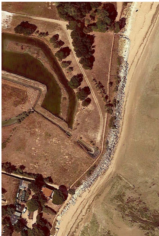
Figure 10 : Secteur des protections en enrochements et en gabions (GoogleEarth 08/2018)
