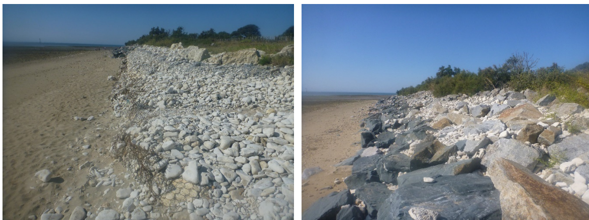
Figure 9 : Gabions empilés (g) et protection en enrochements (d).
