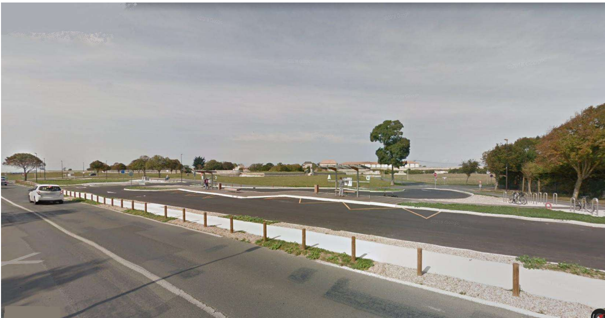
Figure 16 : Exemple de Pôle d'échanges équipé de quais dédiés accessibles – Saint-Martin-de-Ré
