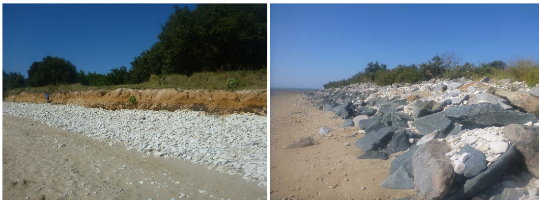
Figure 1 : Zone de falaises au sud entre la Pointe Chauveau et la protection en enrochements (g) et zone centrale avec les protections en enrochements au niveau de l'ancienne ferme ostréicole du Défend (d).
