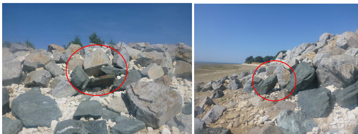
Figure 13 : Enrochements en équilibre précaires.
