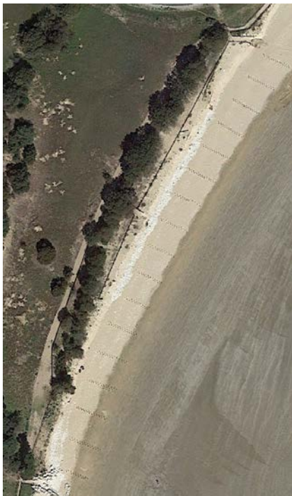
Figure 14 : Secteur des épis en pieux bois (GoogleEarth 04/2014)
