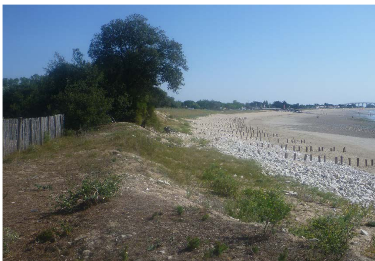
Figure 15 : Vue de la zone nord où sont localisés les épis en piex bois.
