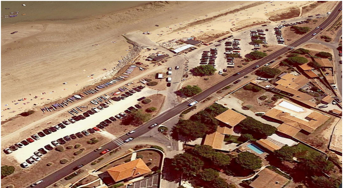
Figure 22 : Aire de stationnement côté Ré Glisse : 150 véhicules dénombrés
