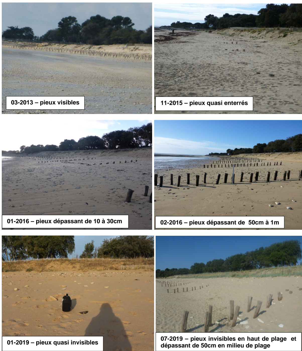
Figure 35 : Photographie montrant l'évolution du niveau de plage dans le temps sur le secteur de la plage avec les épis en pieux bois.
