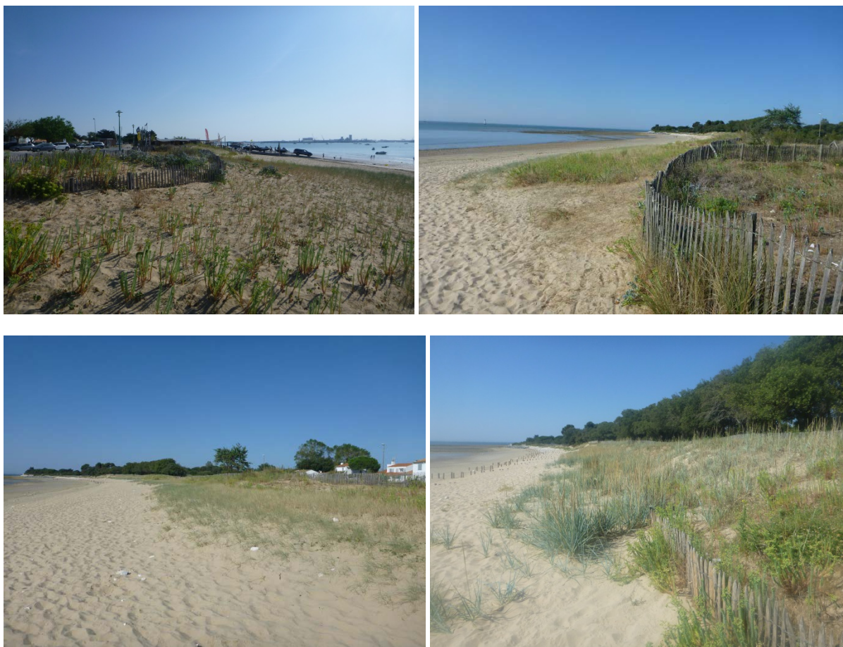
Figure 36 : Ganivelles mises en place au niveau des cordons dunaires sous la forme de casiers ou de façon linéaire, de l'est vers l'ouest.
