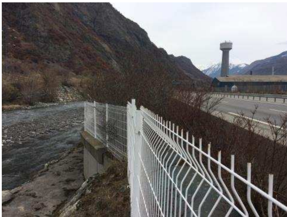
Photo 2 : Vue en rive gauche, vers l'amont de l'Arc, au niveau du château d'eau
