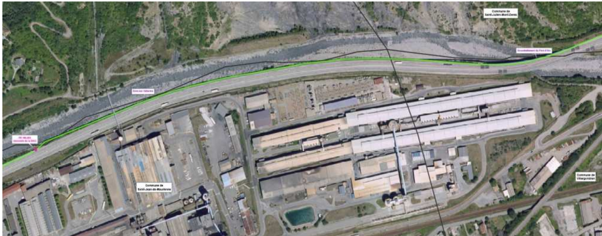
Figure 3 : Vue aérienne du projet
