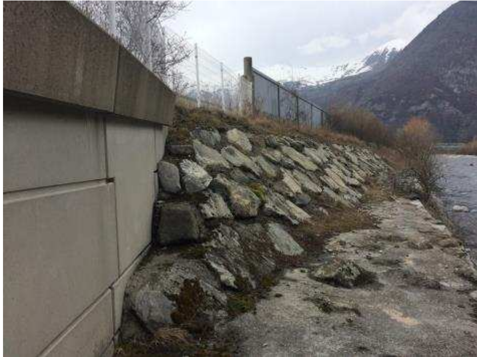
Photo 1 : Vue en rive gauche, vers l'aval de l'Arc
