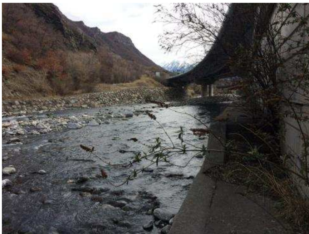
Photo 5 : Vue en rive gauche, vers l'amont de l'Arc, au niveau du pont
