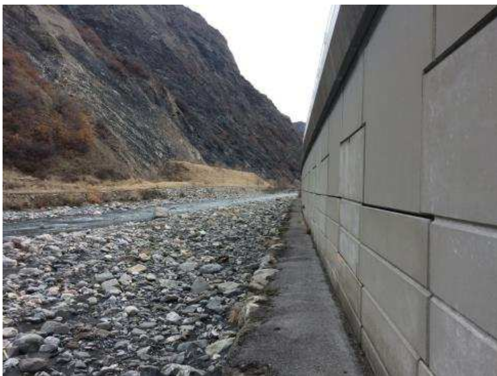
Photo 3 : Vue en rive gauche, vers l'amont de l'Arc, le long du mur en écaille
