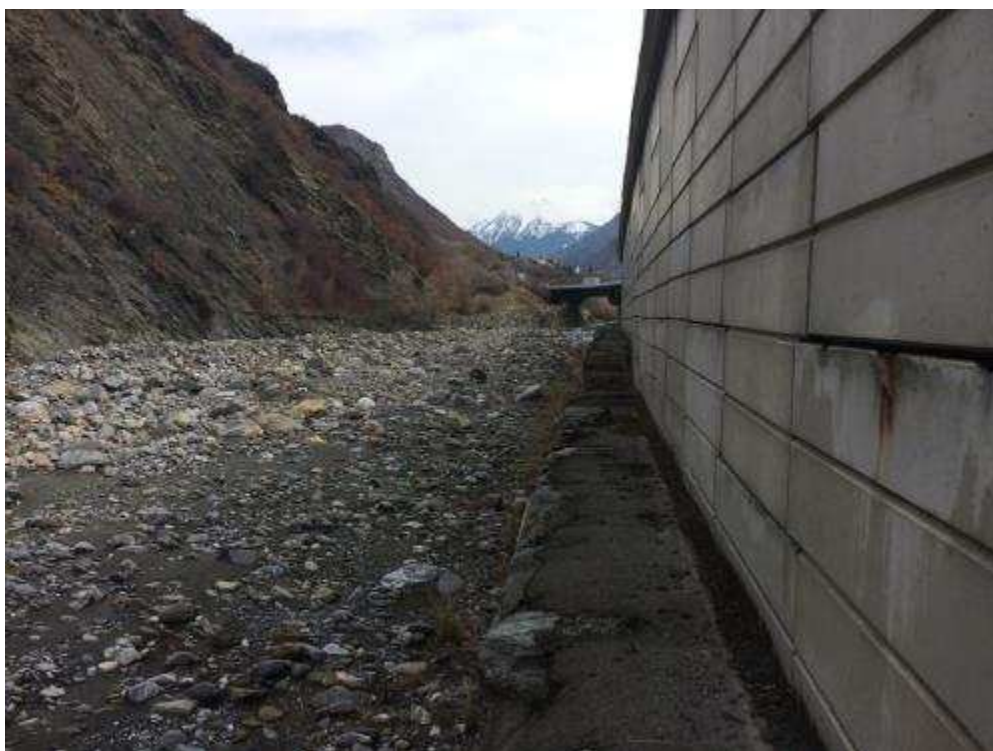
Photo 4 : Vue en rive gauche, vers l'amont de l'Arc, le long du mur en écaille
