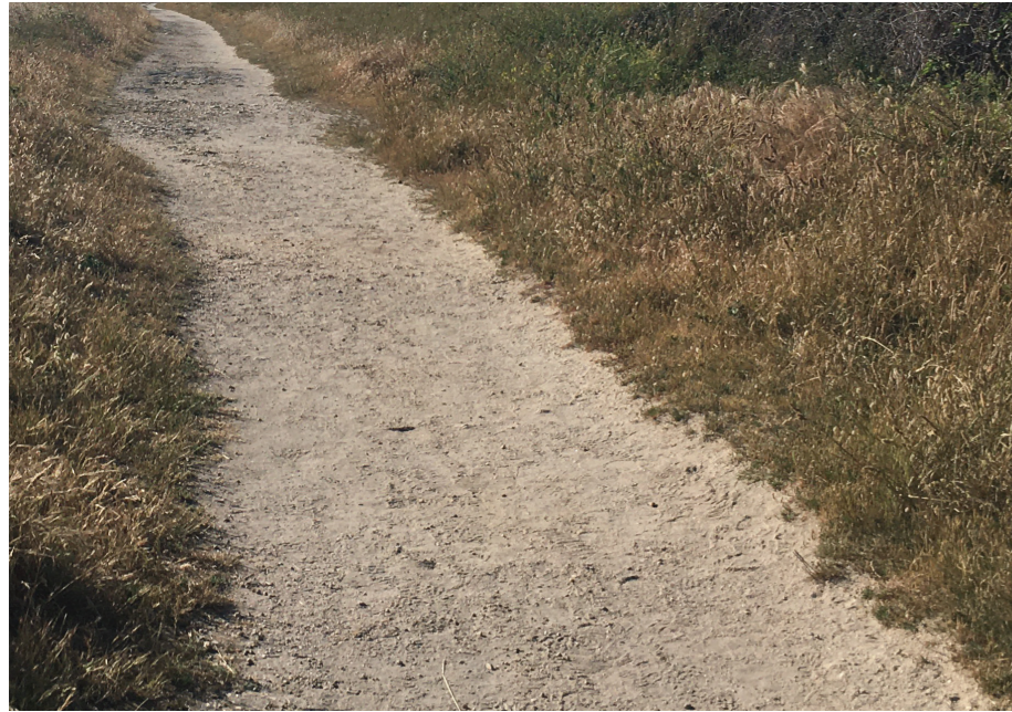
Cheminements piétons en stabilisé
