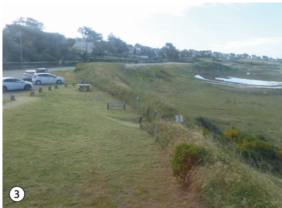
3 Vue du remblai existant depuis la Maison du Littoral - Limite entre l'espace de stationnement et les dunes
