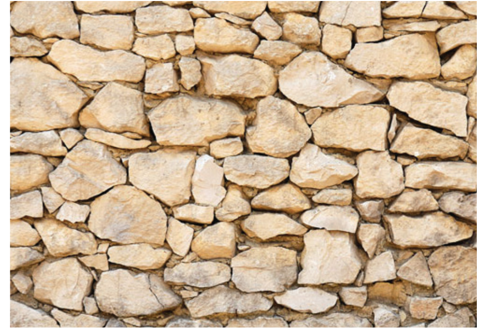
Matériaux pour les murets en moellon pierre // Matériaux identiques aux ruines de la Maison du Littoral
