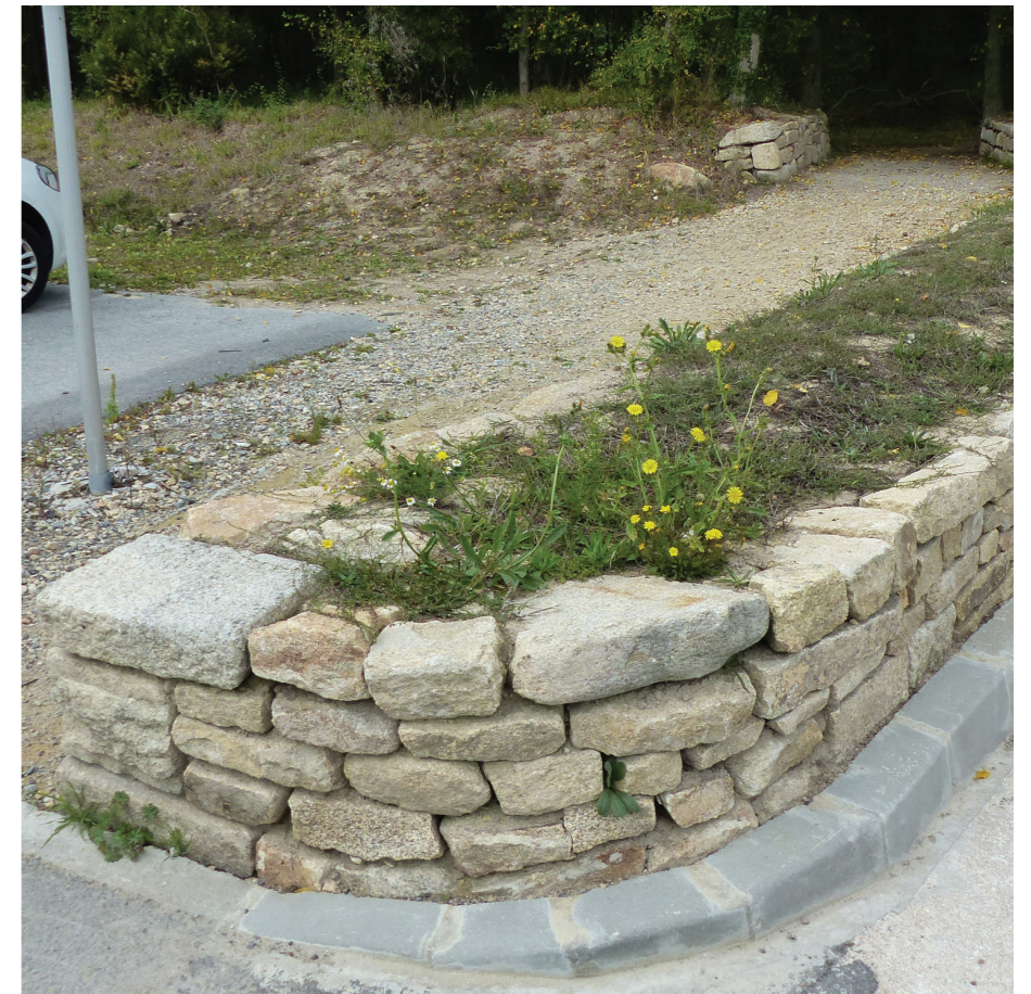
Murets en pierre plantés qui intègrent les places de stationnement bus
