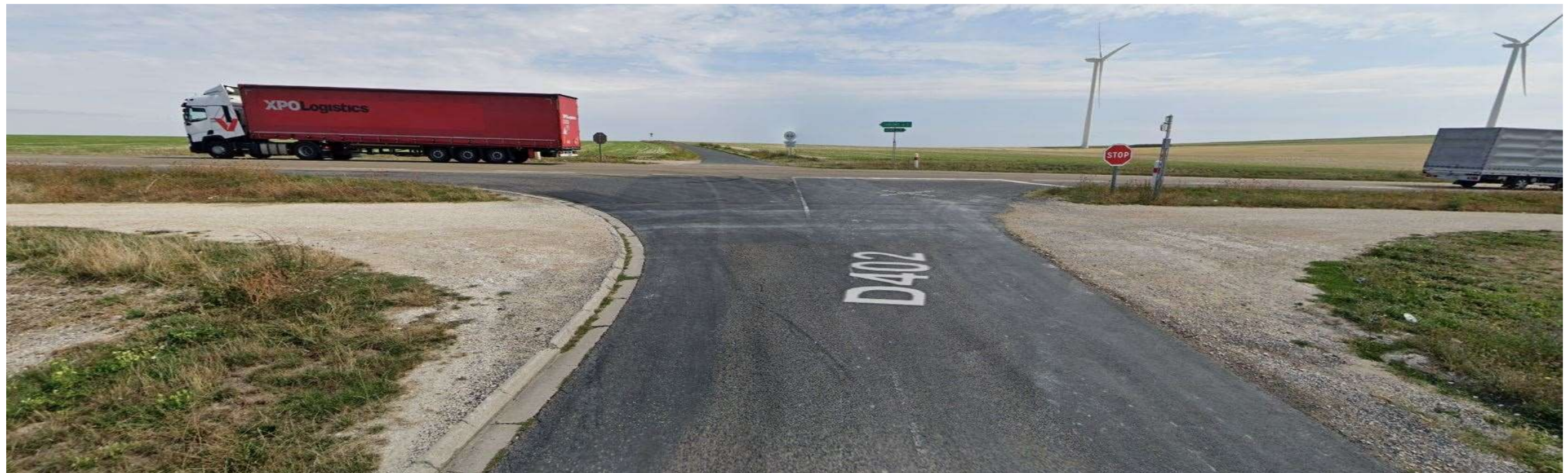
Photo n°2 – août 2018 – Vue depuis la RD402 sur le carrefour actuel avec la RN44 (fermeture des accès)
