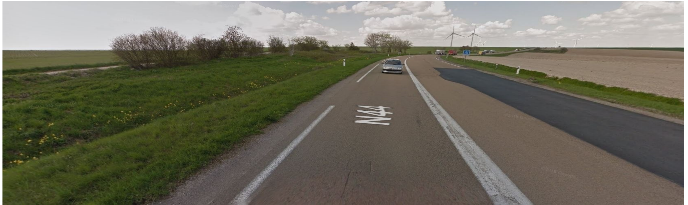
Photo n°5 – avril 2016 – Vue depuis la RN44 vers La Chaussée-sur-Marne sur l'emplacement du futur giratoire
