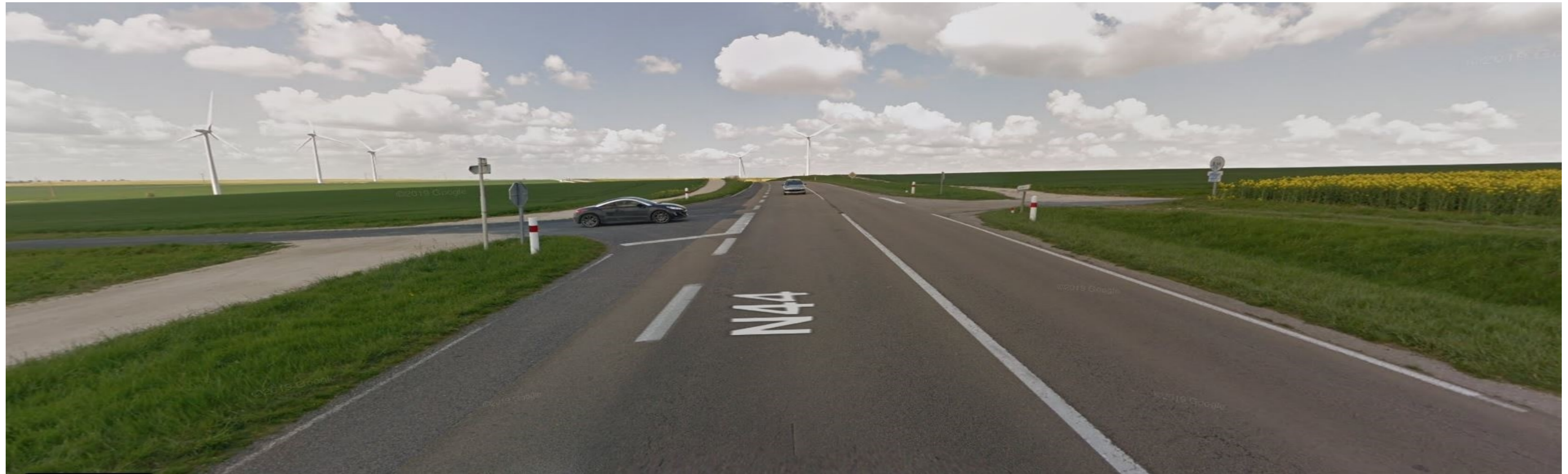
Photo n°3 – avril 2016 – Vue depuis la RN44 vers La Chaussée-sur-Marne sur le carrefour actuel avec la RD402 (fermeture des accès)
