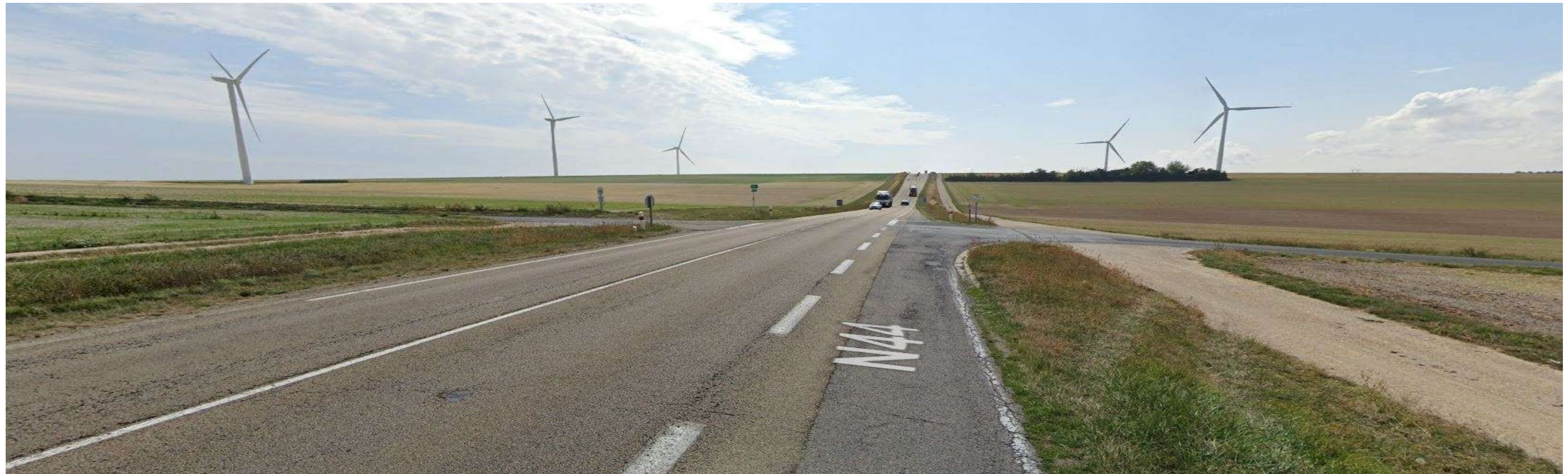
Photo n°1 – août 2018 – Vue depuis la RN44 vers Vitry-le-François sur le carrefour actuel avec la RD402 (fermeture des accès)
