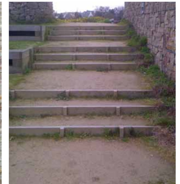
Marches en bois remplissage sablé
