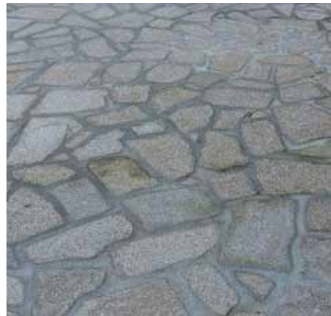
Dalles granit pour opus incertum sciées et flammées pour accessibilité PMR au niveau de l'entrée de la Maison du site
