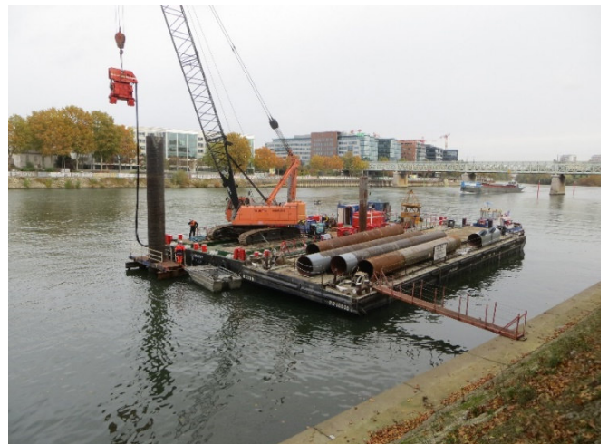
Réalisation de la première phase de travaux
