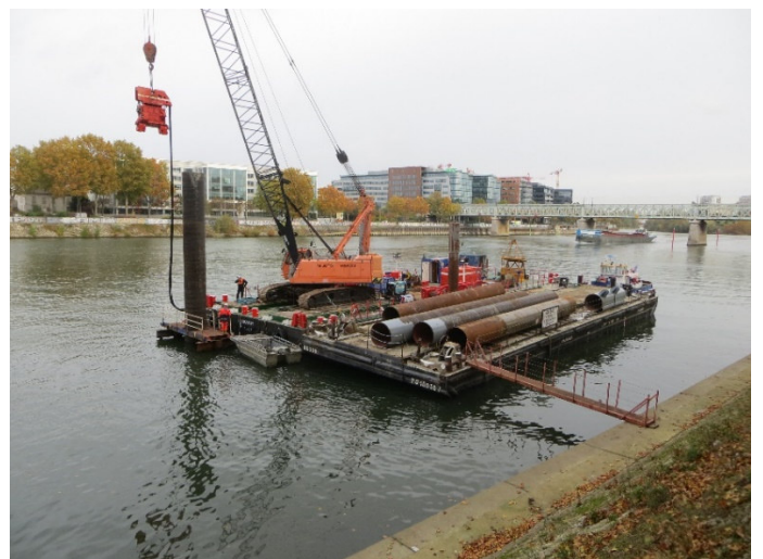
Réalisation de la première phase de travaux (BIEF)
