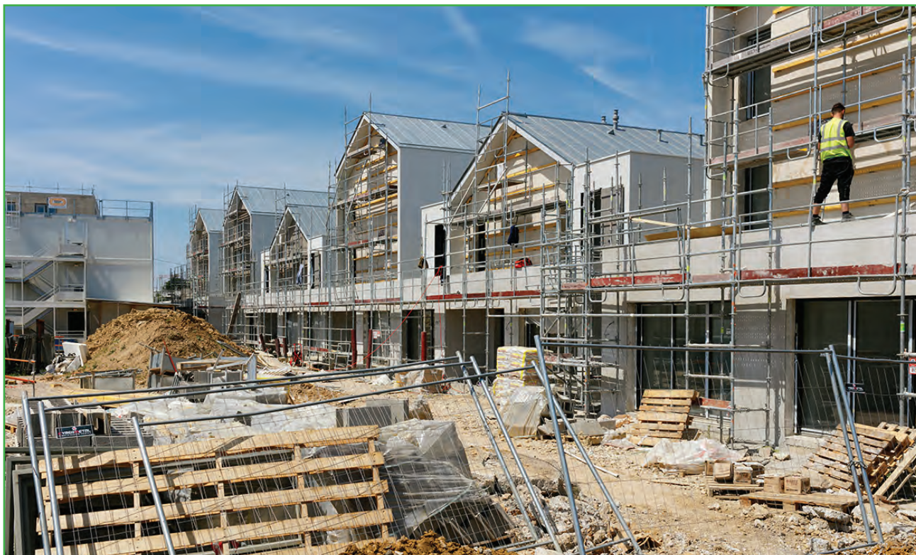
La ZAC Charles Renard en cours de construction
