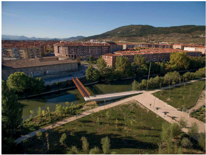
Un parcours piéton indirect Rio Arga, Passerelle piétonne, Espagne
