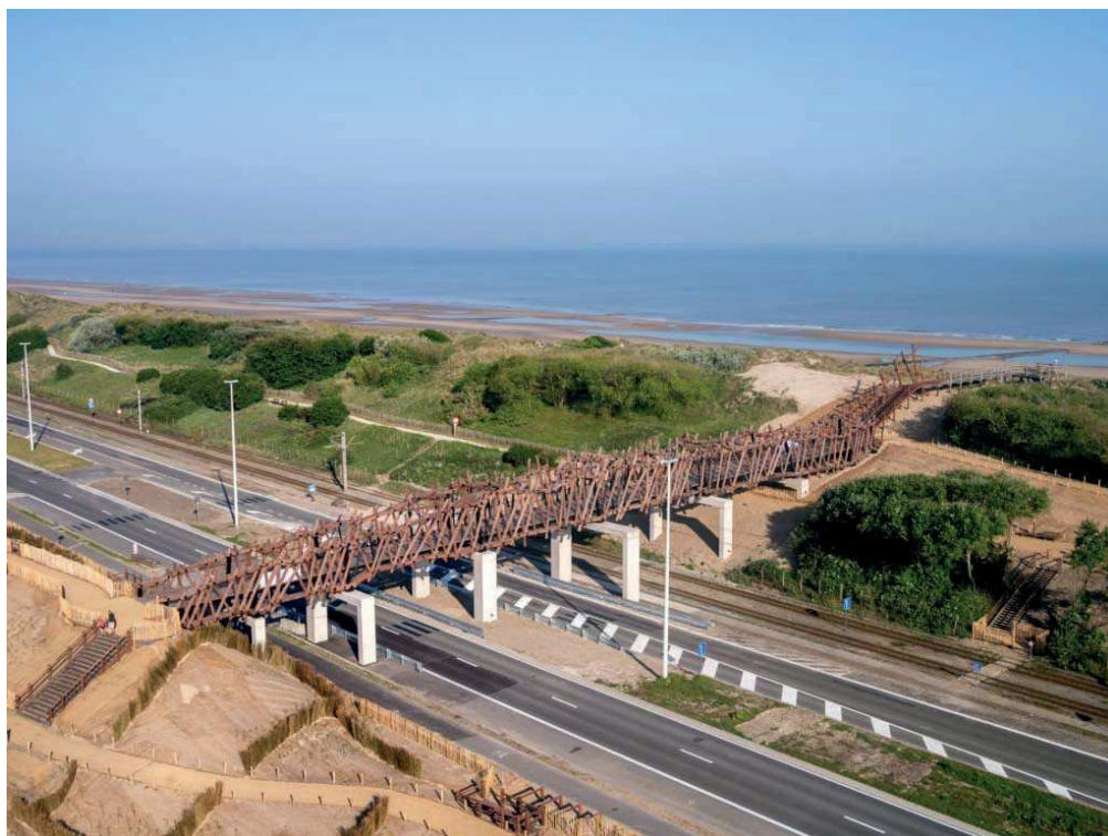
Des accès multiples et différenciés Passerelle piétonne, Wenduine, Belgique
