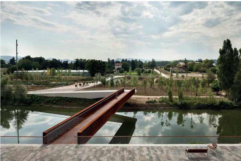
Deux accès bien différenciés Rio Arga, Passerelle piétonne, Espagne
