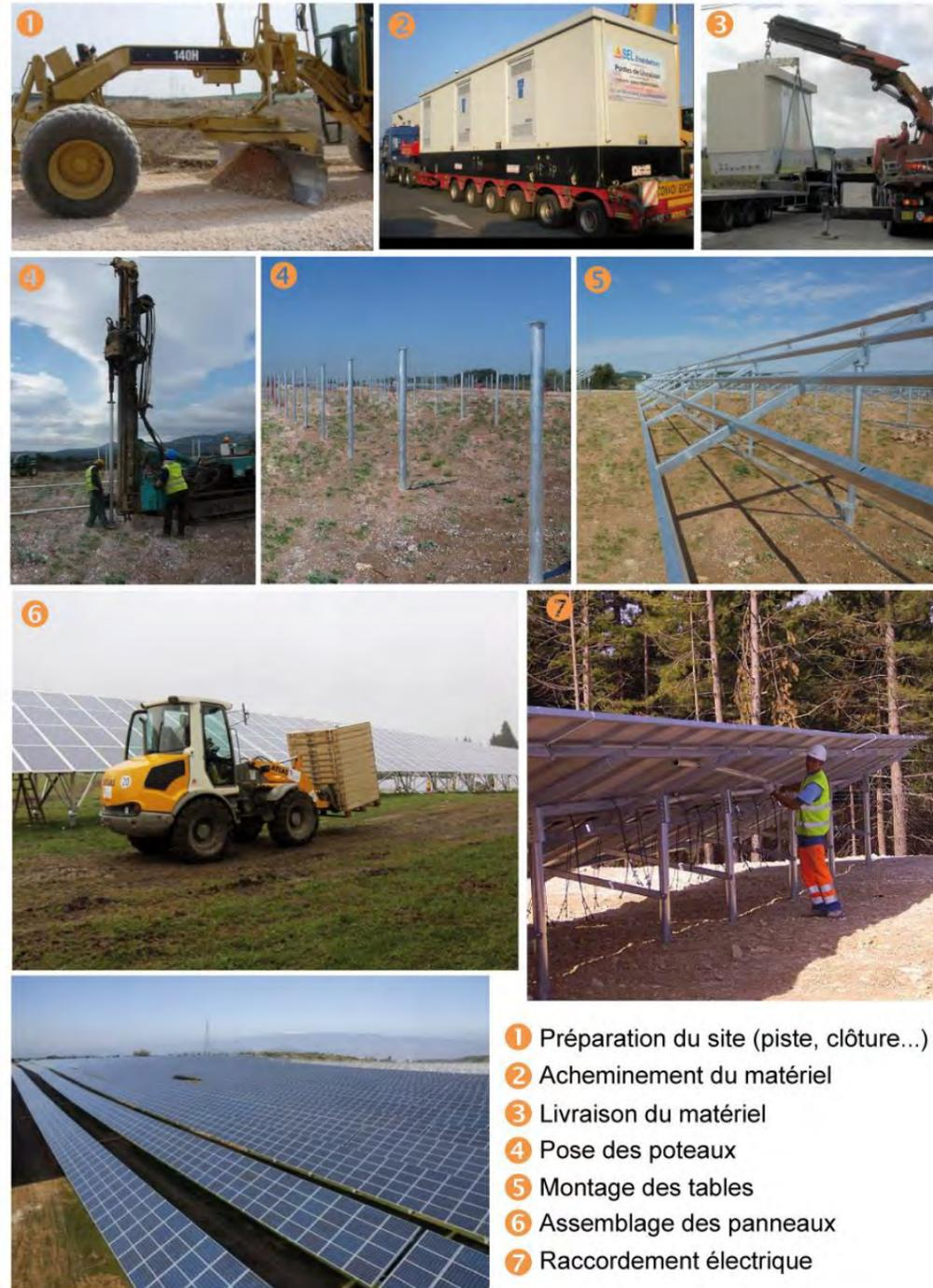
Photographie 1 : Construction d'une centrale photovoltaïque
