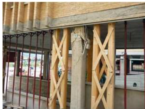
Exemple d'irrégularité en élévation avec possible formation d'étage souple. Séisme de L'Aquila 2009. Hôpital de L'Aquila
