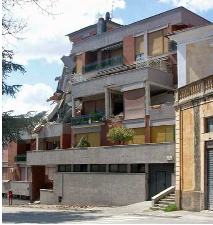
Exemple d'irrégularité en plan et en élévation avec formation d'étage souple. Séisme de L'Aquila 2009. Bâtiment de la rue Porta Napoli. Avant et après le séisme
