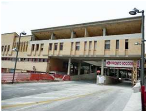
Exemple d'irrégularité en élévation avec possible formation d'étage souple. Séisme de L'Aquila 2009. Hôpital de L'Aquila
