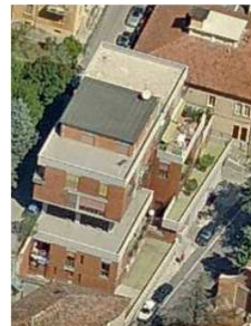
Exemple d'irrégularité en élévation avec possible formation d'étage souple. Séisme de L'Aquila 2009. Hôpital de L'Aquila
