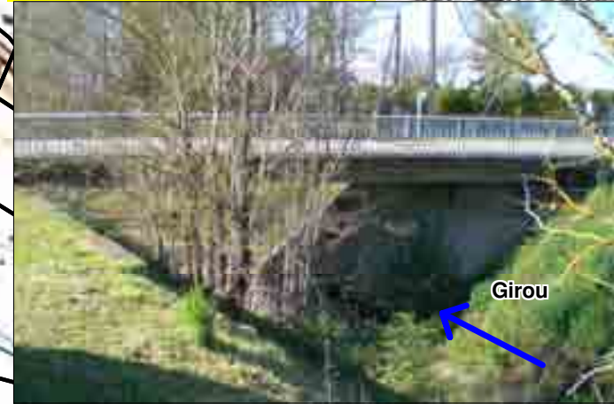
P284 / (face amont ouvrage RD112)
