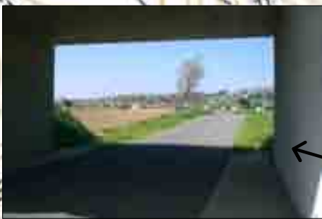
P283 / (vue lit majeur RD depuis la passage inferieur sous le remblais de la RD20)
