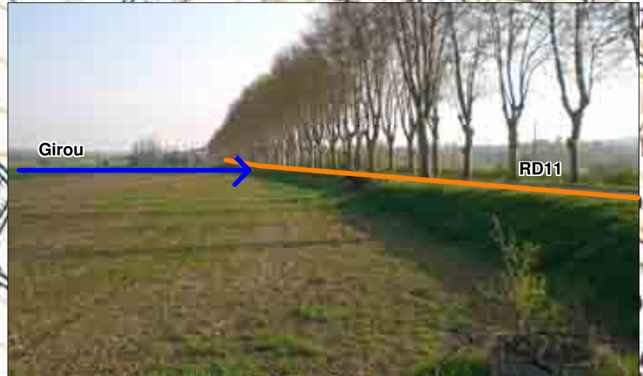
P148 / (face amont de la RD11 sur remblais en rive droite depuis la RD20)
