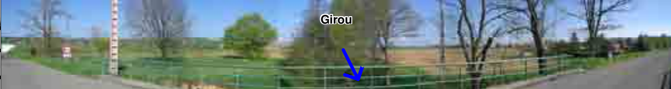
P277-P282 / PA27 (vue globale amont RDRG depuis la RD77d dans l'axe du Girou)
