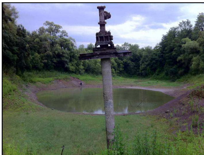
Figure 14 : Vue de la zone des effondrements des sondages S27 et S26 de la piste 1. Au premier plan la structure visible correspond à un sondage (le S28 probablement).
