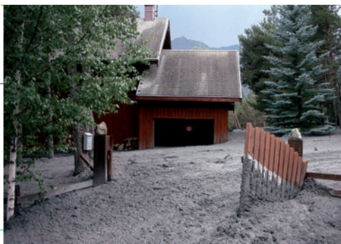
Conséquence de la lave torrentielle du 5 août 2003 à Faucon-de-Barcelonnette (ONF-RTM 04)
