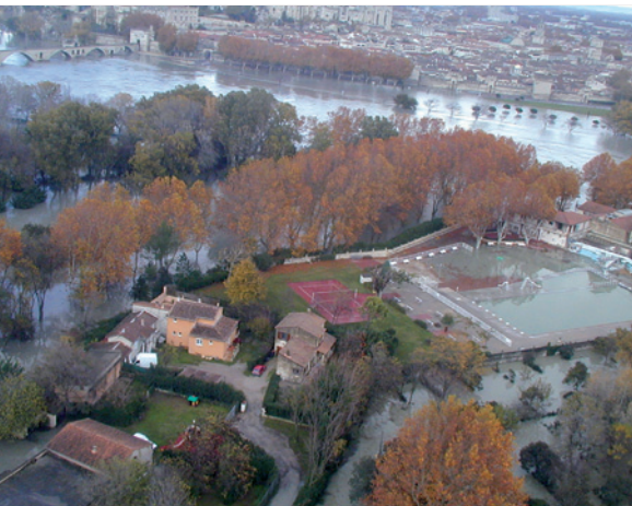
Avignon, inondation du 2 décembre 2003 (SDIS 84)
