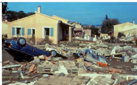
Dommages dus à l'inondation survenue à Vaison-la-Romaine (SDIS 84)
