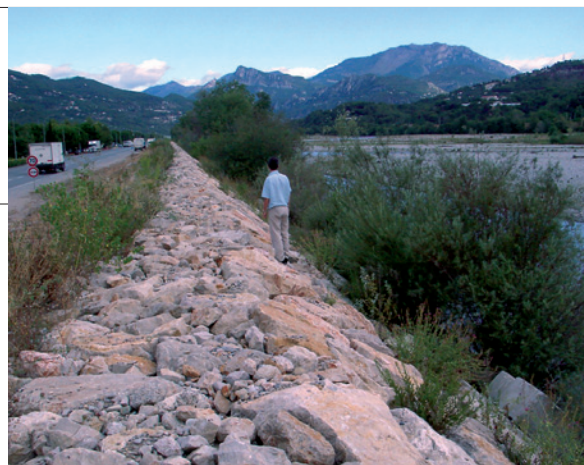
Digue de protection le long de la route départementale sur la berge du Var (DDTM 06)
