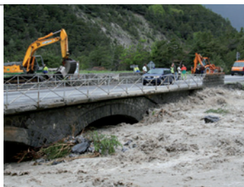
Fort dépôt de matériaux lors de la crue de l'Ubayette, "Les Gleizolles" mai 2008 (ONF - Service RTM 04)
