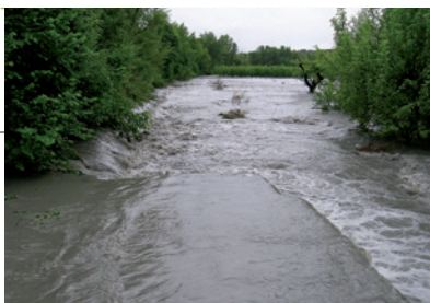
Rupture de digue à Monétier Allemont (05) lors de la crue de mai 2008 (SMAVD)
