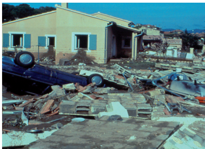
Dommages dus à l'inondation survenue à Vaison-la-Romaine en 1992 (SDIS 84)
