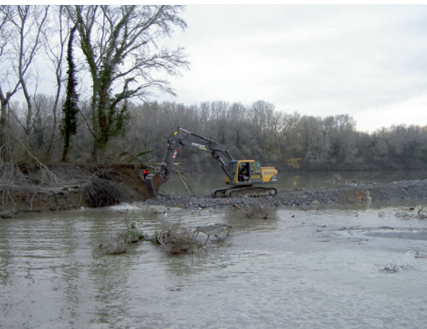
Intervention sur brèche (Symadrem)
