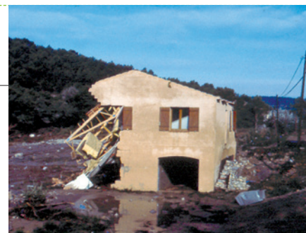
Inondation d'un lotissement de Vaison-la-Romaine (SDIS 84)
