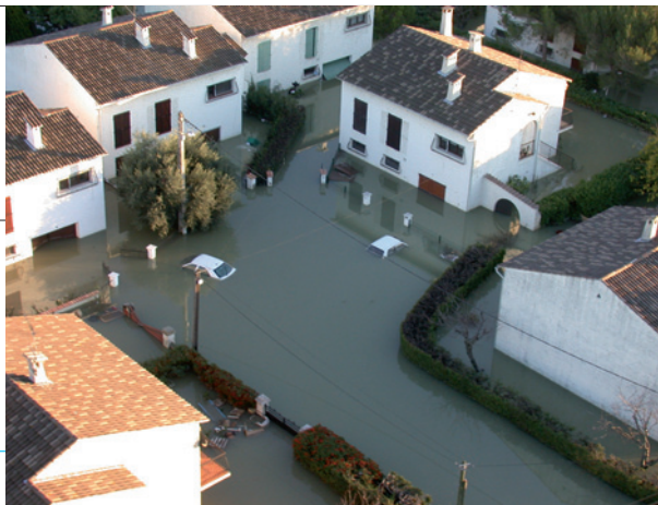
Inondation d'Arles lors de la crue de décembre 2003 (Mairie d'Arles)
