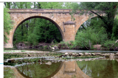
Pont sur l'Argens à Vidauban (J-M. Morand DDTM 83)
