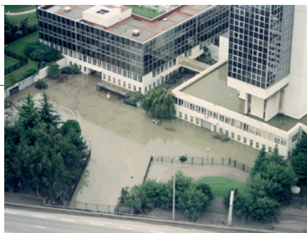
Inondation du Centre administratif des Alpes-Maritimes lors de la crue du Var en 1994 (SDIS 06)
