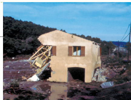
Inondation d'un lotissement de Vaison-la-Romaine (SDIS 84)
