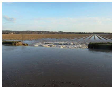
Brèche dans le Vigueirat lors de la crue du Rhône décembre 2003 (Cemagref)
