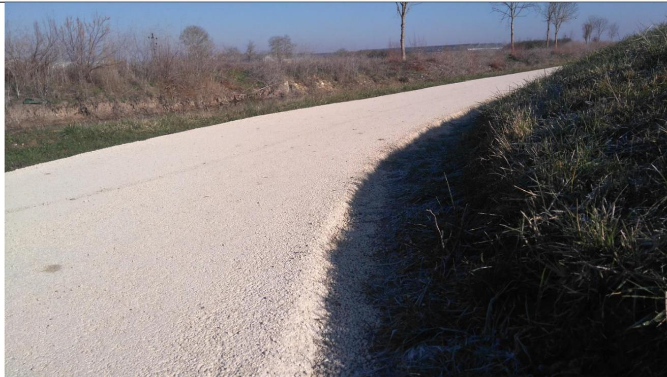
FIGURE 10 : EXEMPLE DE CHEMIN SABLE CALCAIRE
