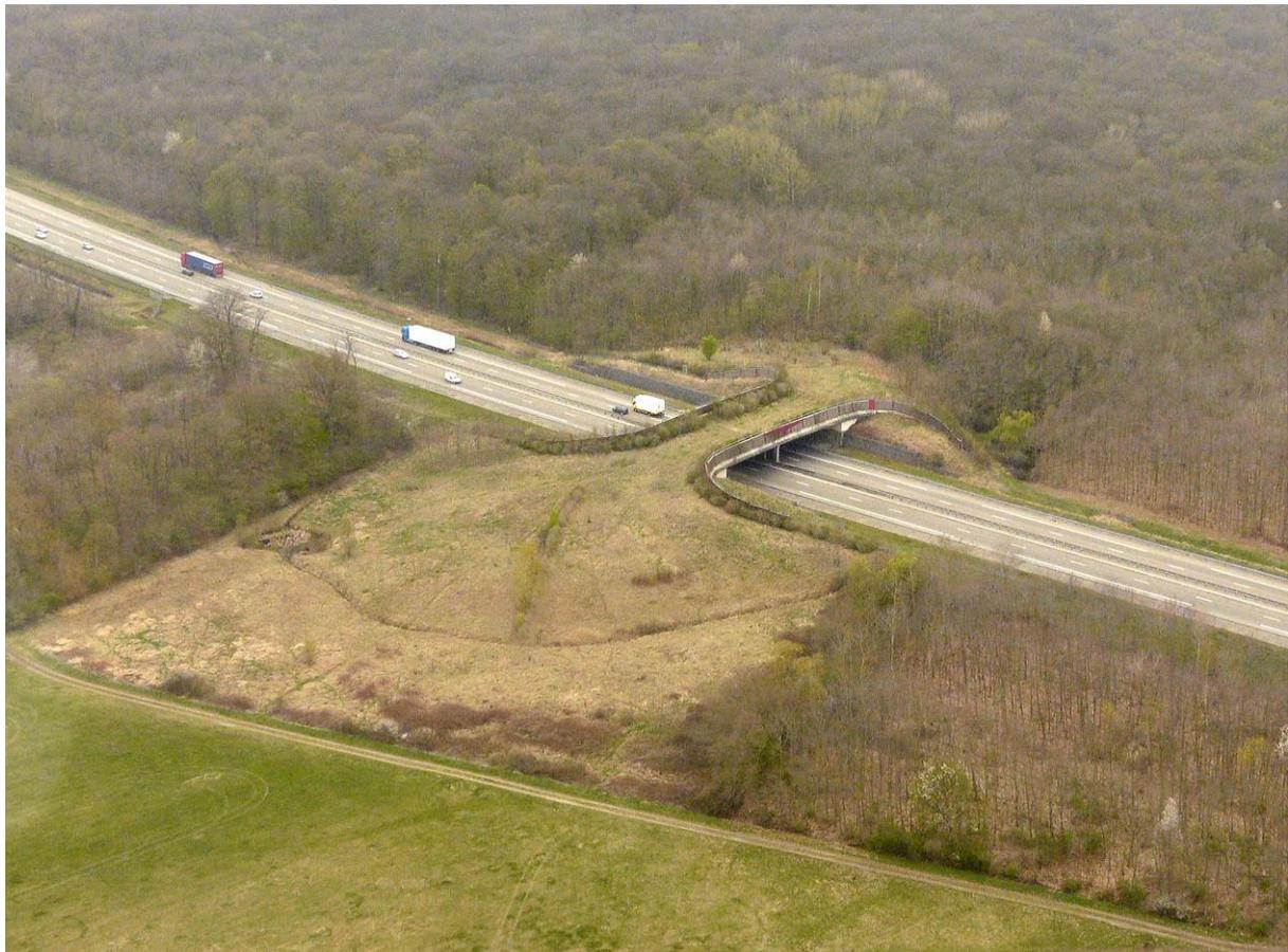
Passage faune spécifique de 20 m de large sur A35 à Epfig (Bas-Rhin), le 8 avril 2008. L'autoroute au niveau du terrain naturel a nécessité des remblais pour atteindre la hauteur du gabarit autoroutier. Malgré des rampes dissymétriques dont l'une est plus pentue, cet ouvrage est utilisé par les cerfs, chevreuils, sangliers, les carnivores... ©O.G.E./V. Vignon
