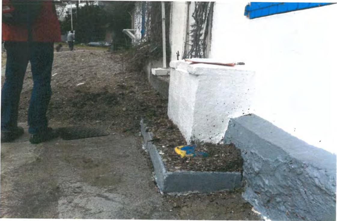
Figure 5. Photographie du 20/01/2016 mettant en évidence le dépôt d'un mélange de sable et de Posidonie recouvrant le socle béton et le pied du mur (cote > 2 m NGF). A noter que la portion basse de l'image a été fraîchement nettoyée au jet d'eau.
