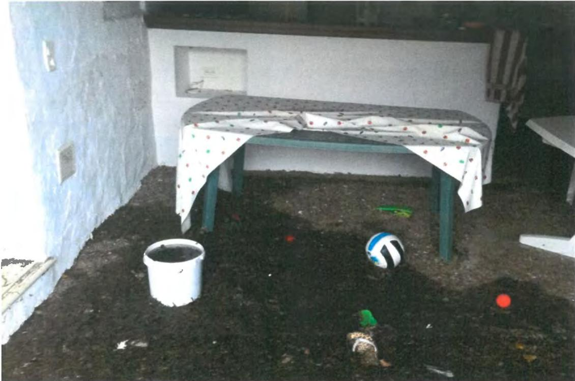
*Figure 7. Photographie du 20/01/2016 mettant en évidence le dépôt d'un mélange de sable et de Posidonie à l'intérieur de la construction mitoyenne au Nord du local de la Figure 6 (cote > 2 m NGF).*
