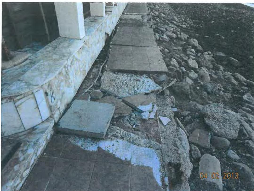
Dalle béton de l’Eden endommagée par les flots et amas de galets et matériaux chariés par la mer
