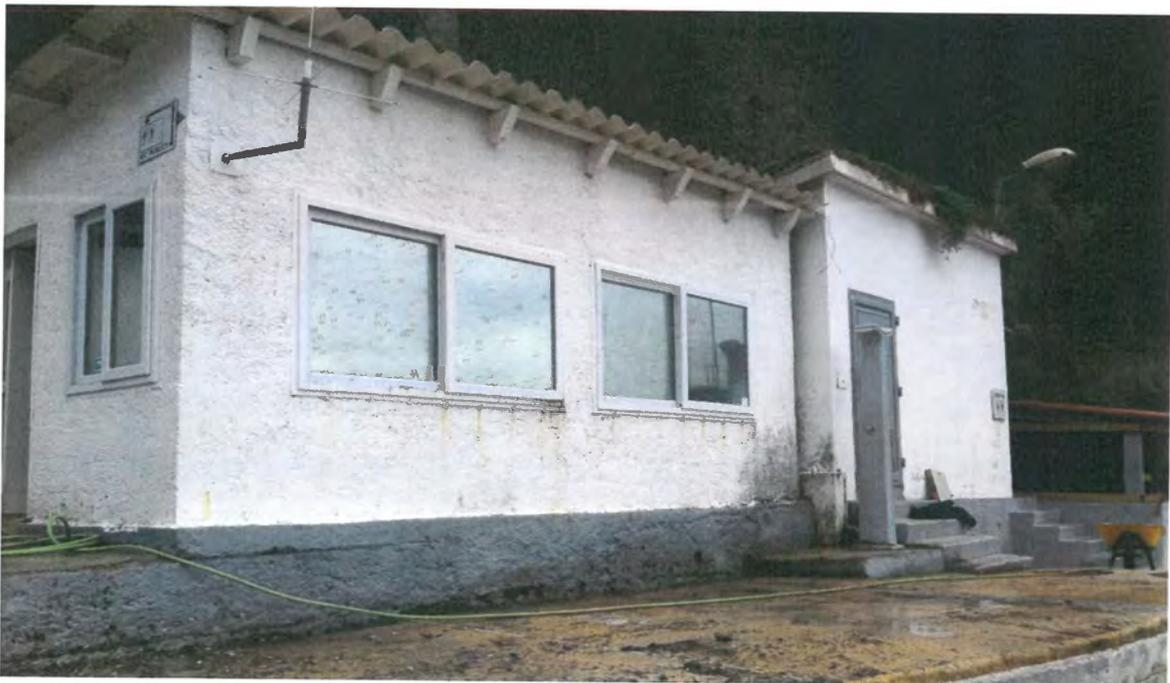
Figure 6. Photographie du 20/01/2016 mettant en évidence l'existence d'un déferlement de vagues pouvant dépasser la cote altimétrique de 4 m NGF (herbes de posidonie collées sur les vitres du local situé à proximité des toilettes publiques). A noter que la surface du socle en béton a été fraîchement nettoyée au jet d'eau (portion inférieure de l'image).
