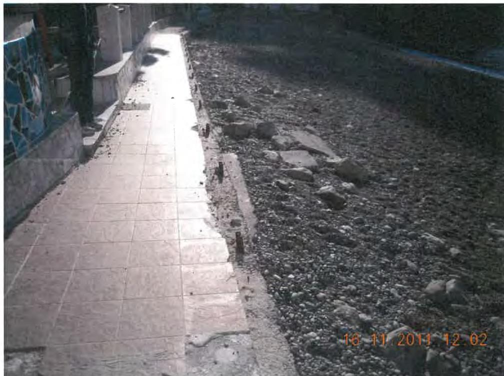
Galets et sable, sur la dalle et accumulés au pied des constructions et dégâts apparents sur la dalle qui borde l'Eden Plage
