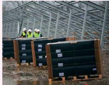
Montage des modules photovoltaïques sur les structures
