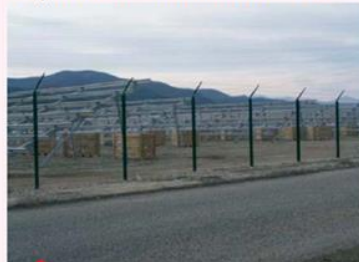
Clôture périphérique du site
