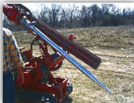
Mise en œuvre de pieux
