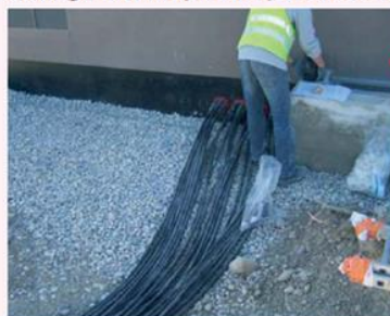
Arrivée des boîtes de jonction à l'un des 4 postes de transformation
