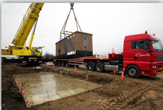
Installation de poste de livraison et de transformation
