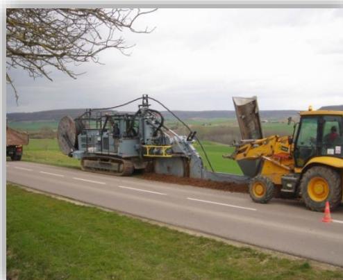
Réalisation de la tranchée
