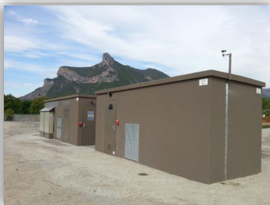
Installation de poste de livraison et de transformation
