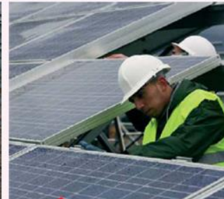
Montage des modules photovoltaïques sur les structures
