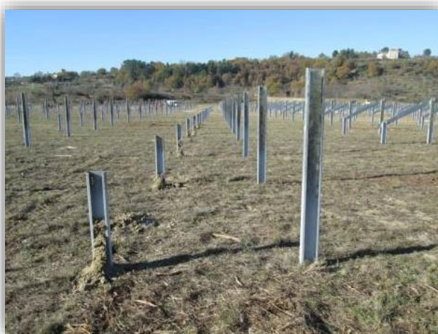
Ancrage des pieux battus
