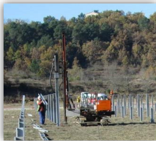
Battage de pieux
