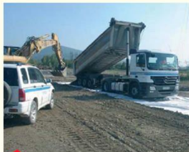
Mise en place de la piste sur géotextile et apport de matériaux stabilisants
