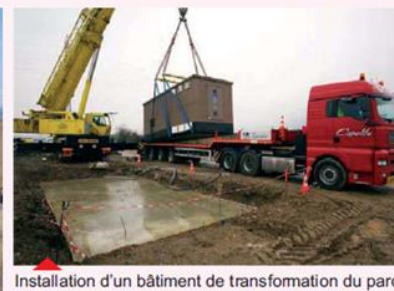
Installation d'un bâtiment de transformation du parc
