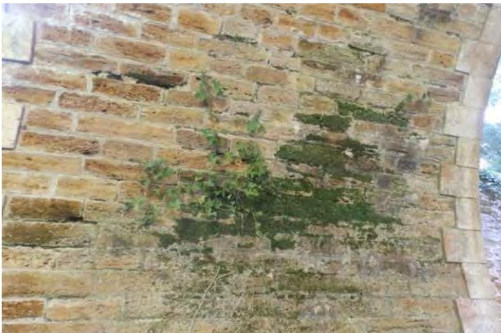
**Figure 25 : Pierre de plinthes dégradée et zone humide en naissance.**
