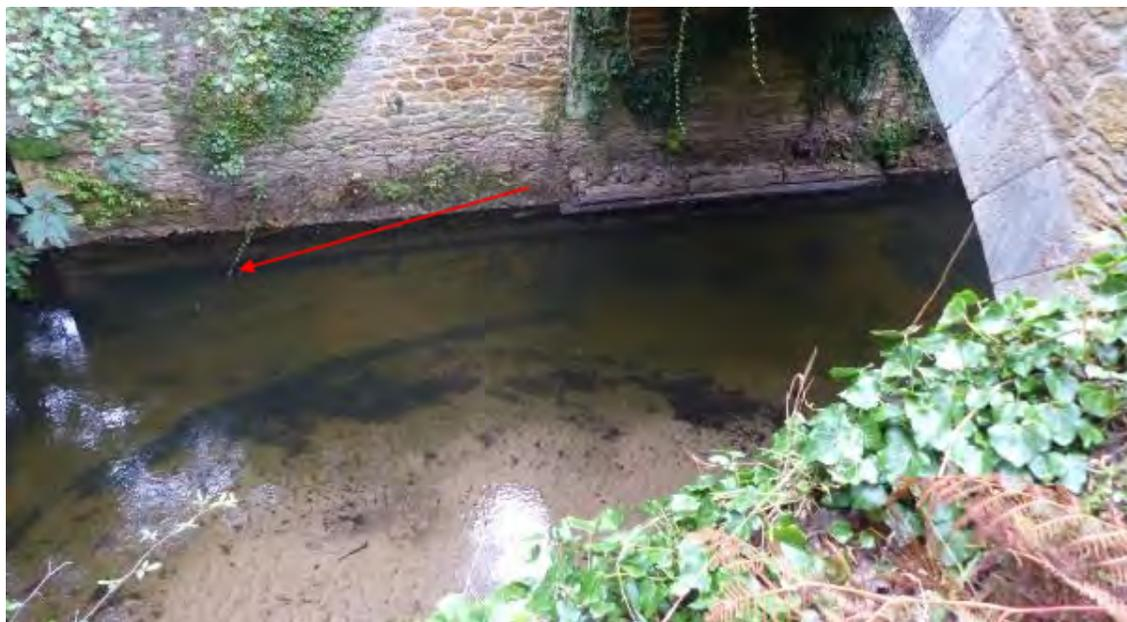
Les travaux proposés consistent en la réalisation d'un remplissage en béton de l'affouillement et de la réalisation d'une protection en béton sur une hauteur de 60 cm environ, ancrée dans la maçonnerie.
