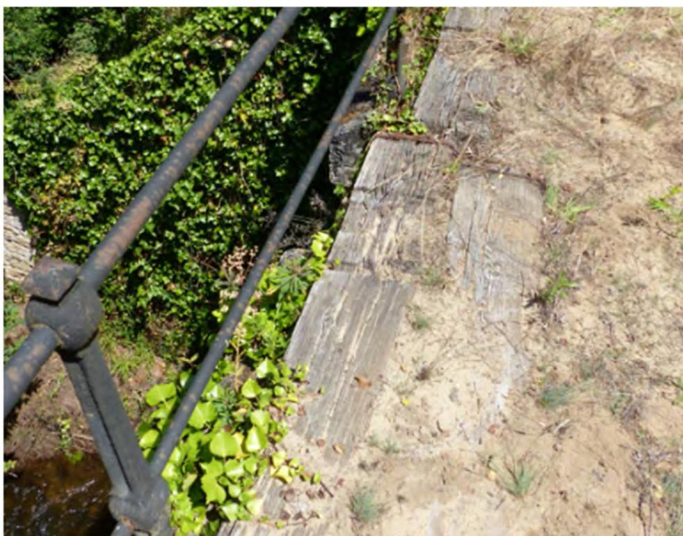
**Figure 29 : Plinthe et garde-corps sur le pont sur le Luzou.**
