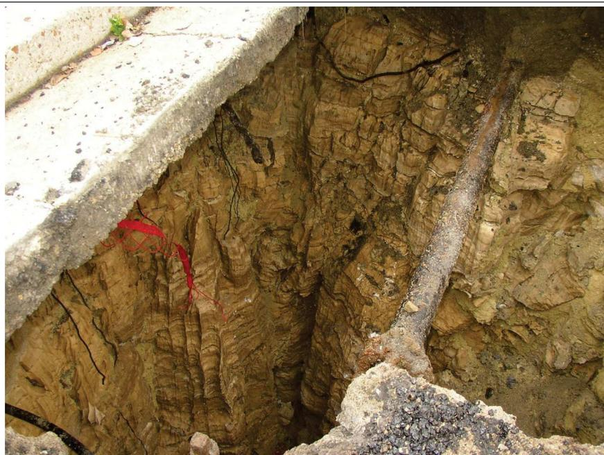
*Photo 6 - Exemple d'effondrement de chaussée suite à des fuites du réseau d'assainissement – Commune de Villetaneuse, butte de Montmorency (photographie source CEREMA)*
