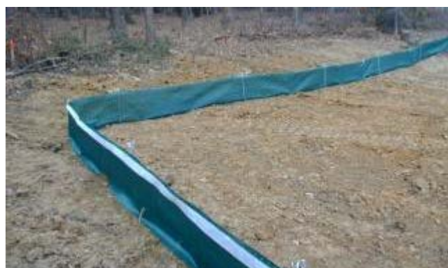
Exemple de barrière de protection des amphibiens (hauteur 50 cm)
