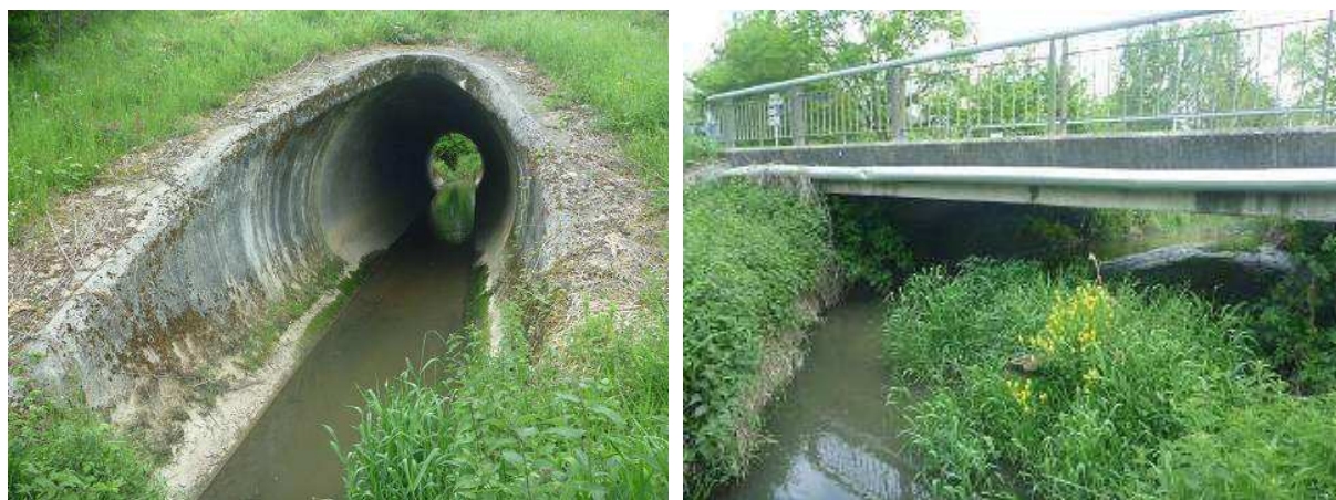
Figure 22. Photographie de l'ouvrage de franchissement de la RN70 sur le Moulin Neuf (à gauche) et du pont de franchissement de la route de Rozelay (à droite).
