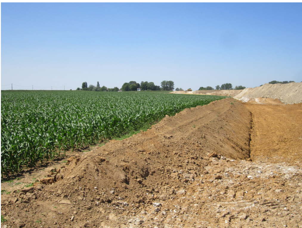
Vue de l'avancement d'une phase d'aménagement de l'ISDI actuelle, en limite d'une zone maintenue en culture
