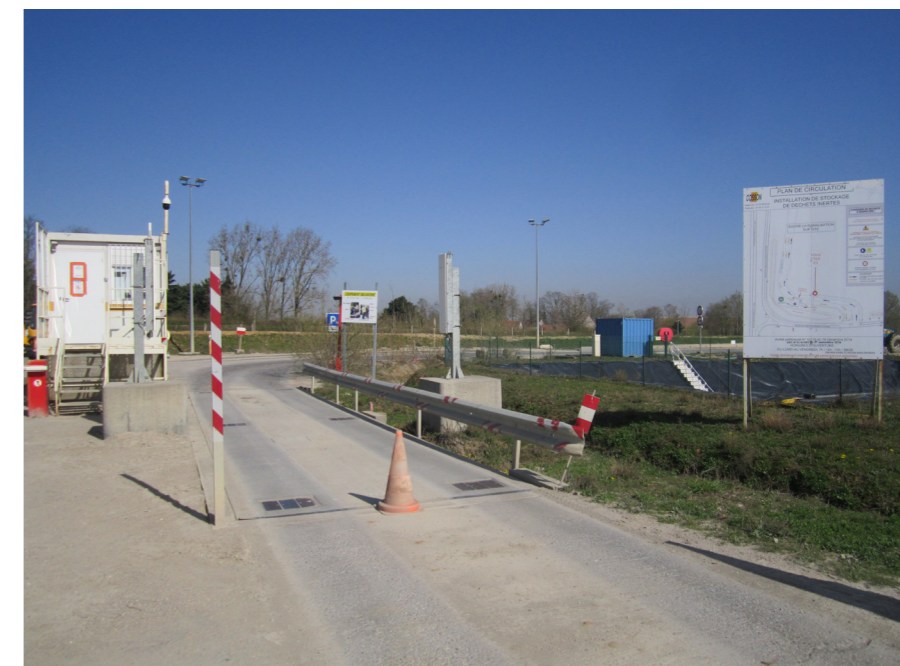
Vue des installations de contrôle d'admission des déchets inertes à l'entrée du site actuel
