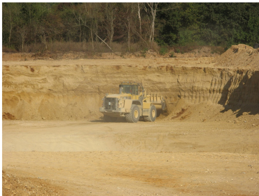
Extraction du gisement à l'aide d'un chargeur dans le secteur 3 (septembre 2016)
