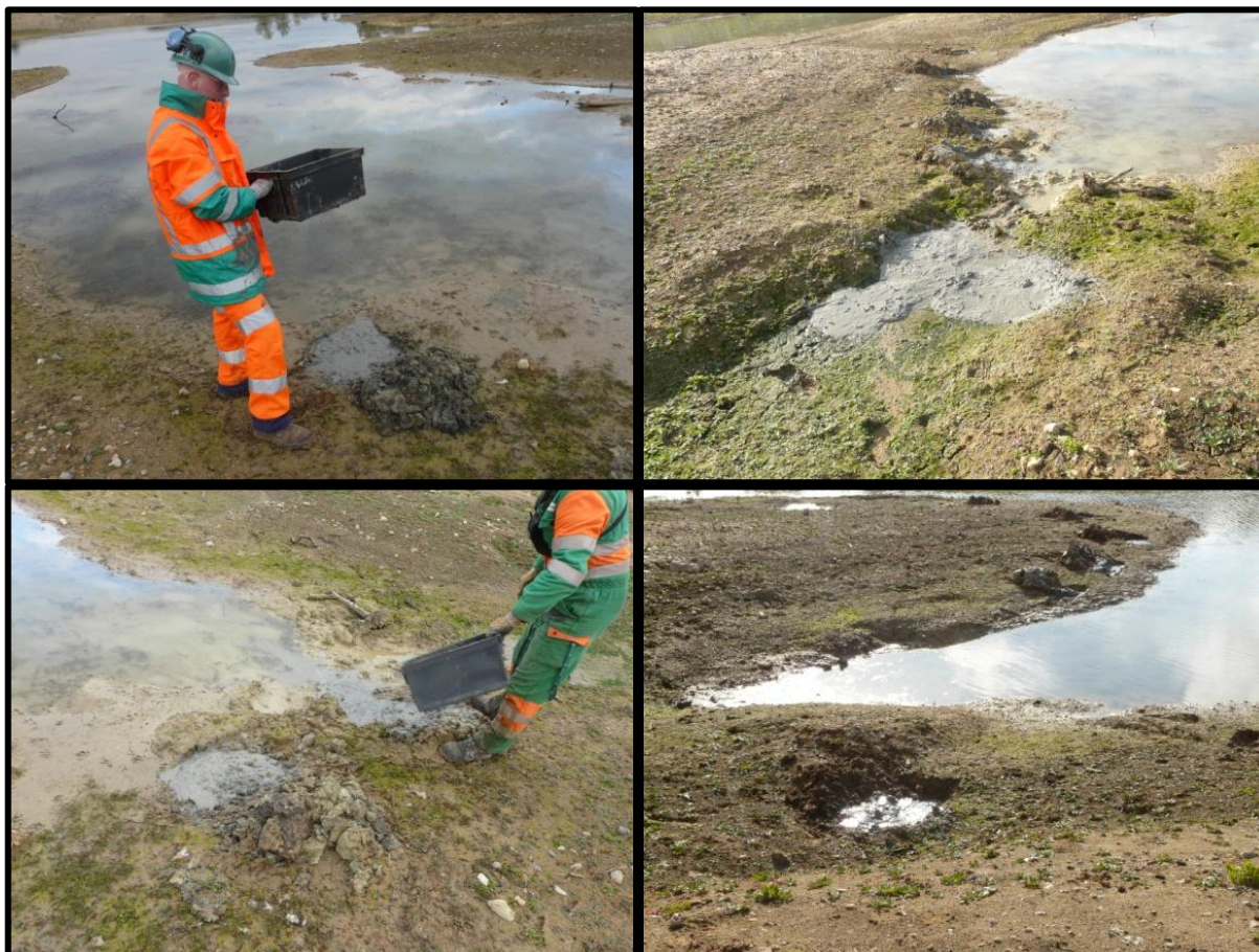
Photo 10 : Déversements des boues dans les casiers (gauche) et casiers remplis (droite) – Source : G. Dujardin
