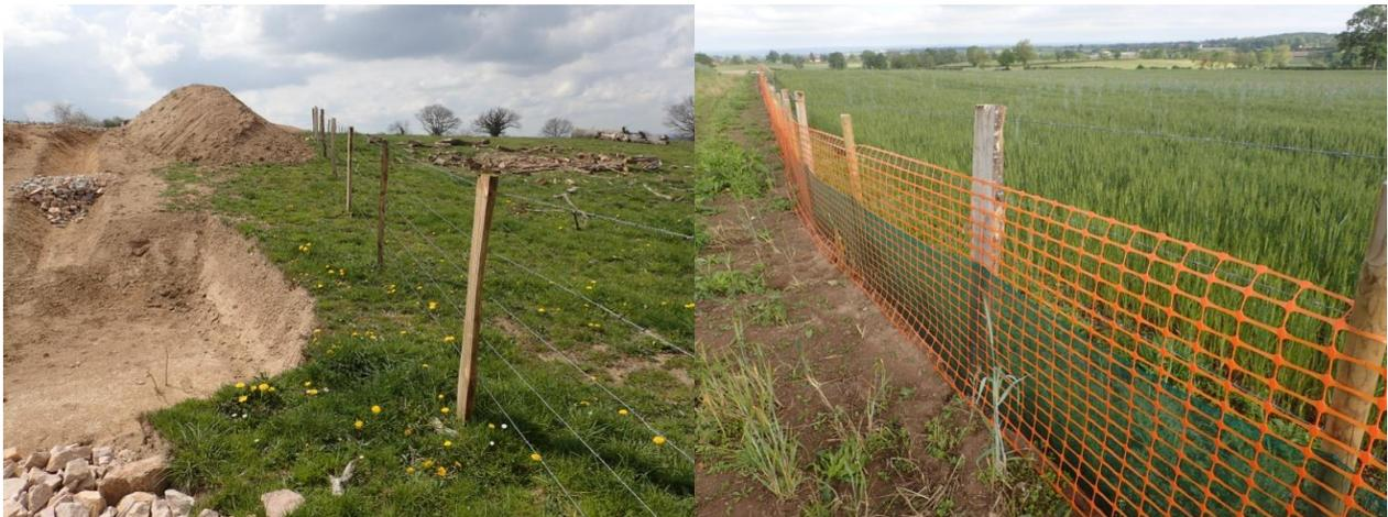
**Figure 15. Exemples de réalisation pour les clôtures de délimitation des emprises de chantier (barbelé agricole simple et avec clôture petite faune)**
