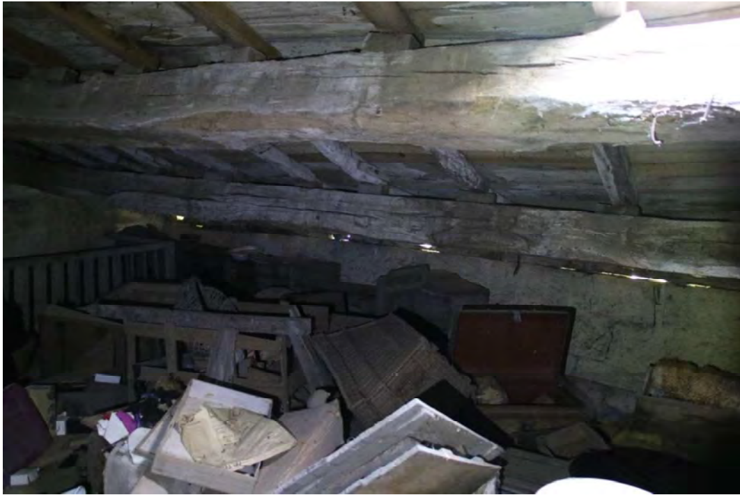
Combles de la maison Audiat – vue 2
