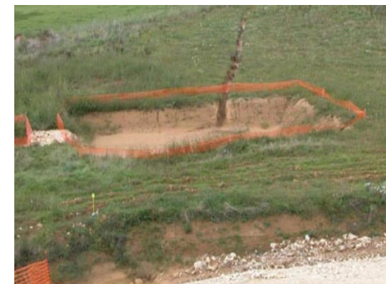
Figure 50: Exemple de fossé de collecte des eaux de chantiers à faible pente (Cerama 2015)
