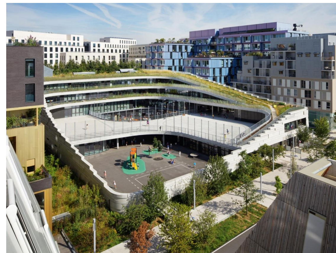
Figure 60: Exemple de toiture végétalisée (source : Groupe scolaire à Boulogne Billancourt Chartier Dalix)
