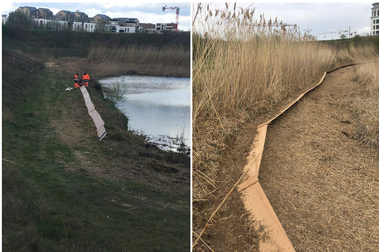
Figure 51: Mise en place des barrières de protection in situ (Confluences 2019)
