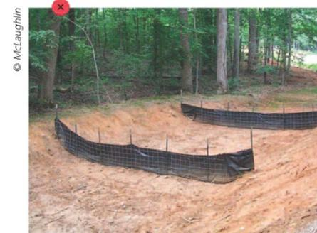
Les barrières perméables en géotextile ne sont pas tendues jusqu'aux talus du bassin de décantation.
