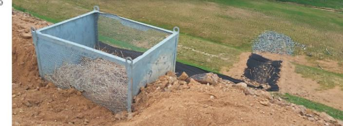
Descente d'eau provisoire sur remblai de grande hauteur, avec passage au travers d'une cage de filtration (en amont) et d'un dispositif anti-érosion (en aval).
