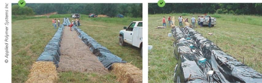
Configuration de traitement pour un pompage et rejet : photo de gauche vue d'aval avec la toile en jute pour retenir les sédiments coagulés, et la photo de droite avec les blocs de PAM attachés le long du fossé de traitement.
