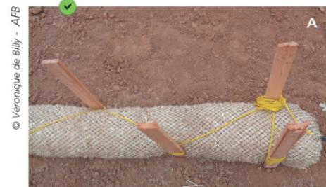
Boudins avec maillage plastique et rembourrage en fibre de paille, ancrés par pieux alternés (A) ou selon la technique "vampire" (B).
