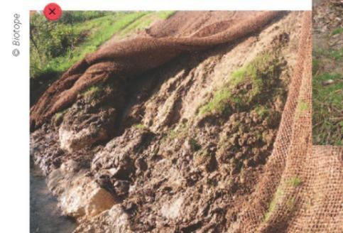
Ancrage insuffisant du filet en amont.
