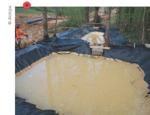
Bassin de décantation inefficace : forme inadaptée ne diminuant pas suffisamment la vitesse du courant et les turbulences hydrauliques.
