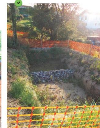
Barrière perméable réalisée à l'aide d'un tas de granulats grossiers.
