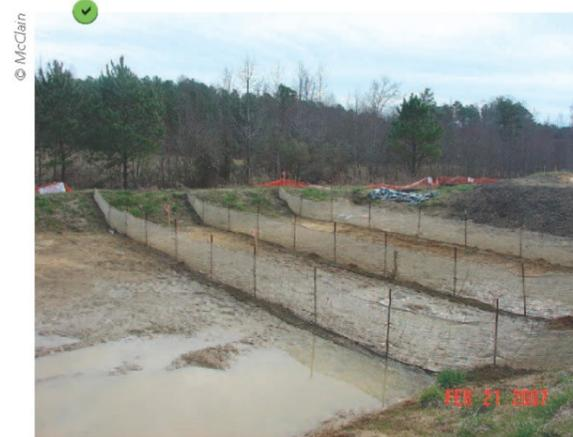
Bassin de décantation équipé de barrières perméables. Une fois le bassin vidangé, les sédiments sont prêts à être curés.
