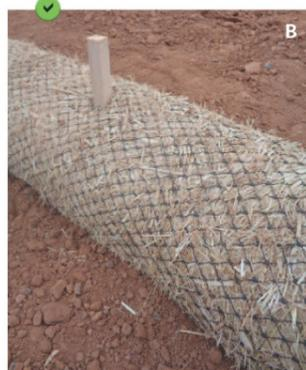
Boudins avec maillage plastique et rembourrage en fibre de paille, ancrés par pieux alternés (A) ou selon la technique "vampire" (B).
