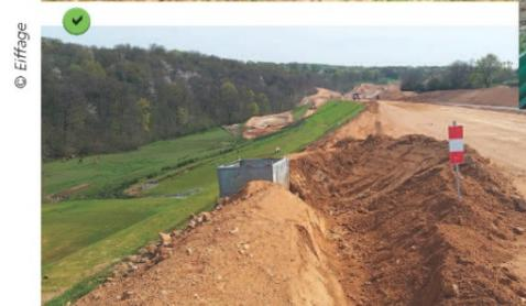
Merlon en bas de pente, associé à une barrière de rétention provisoire en géomembrane et équipé d'une surverse (dans le prolongement de la géomembrane). Il protège une zone humide et un cours d'eau longeant le chantier.
