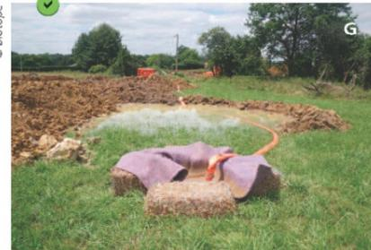
G - Vidange d'un bassin de décantation par infiltration et non rejet des eaux en cours d'eau. Protection du point d'infiltration contre le colmatage, à l'aide d'un filtre constitué d'un géotextile maintenu par des bottes de paille.
