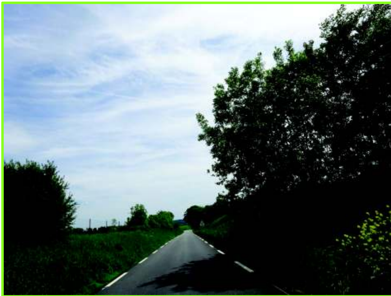
Vue n°4 zoom depuis la RD 619 au Nord à Haillancourt
