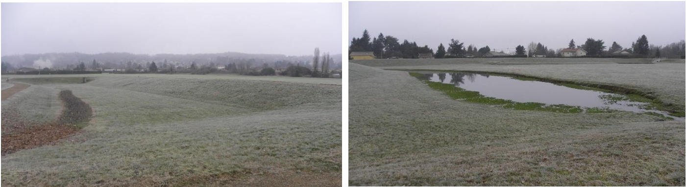
Etat actuel du bassin de rétention situé au Nord-Ouest du périmètre de projet
