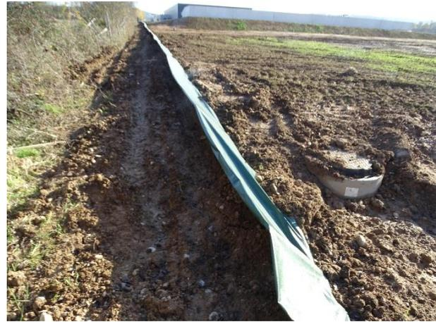
Figure 54 : Exemple de type de barrière anti-intrusion (ECR environnement - photo prise hors site)
