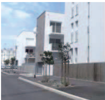
Des percées visuelles dans le quartier
