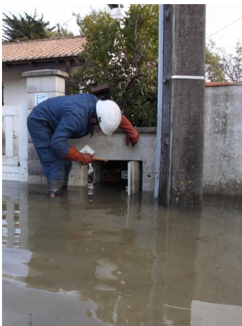
Scrutation d'un coffret de branchement
