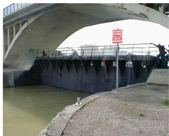
Fin de ballastage et d'immersion de la porte de garde
