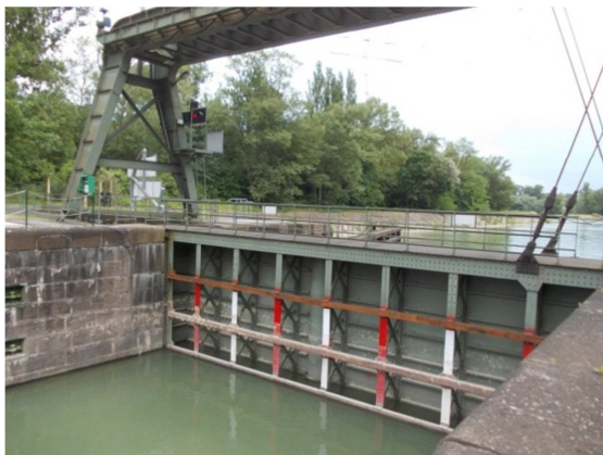
« Porte côté Rhin » de l'écluse sud avec vue vers le Rhin
