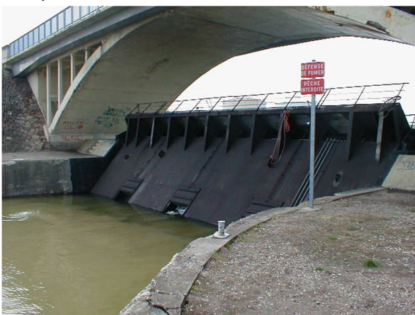
Début de ballastage 72 et d'immersion de la porte de garde
