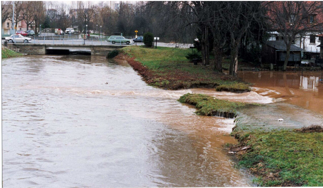
Photographie 3 : Pont de la route de Schirmeck sur le Canal de la Bruche à hauteur de la Holtzmatt (Strasbourg) lors de la crue de 1990. Vue depuis l'amont rive droite
