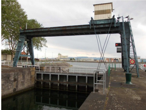
« Porte côté Rhin » du sas nord de l'écluse nord avec vue vers le Rhin
