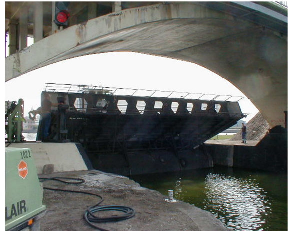
Accrochage de la porte de garde - vue depuis le Port aux Pétroles
