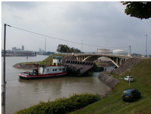
Approche de la porte de garde dans la passe du bassin du Port aux Pétroles
