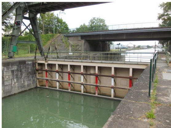
« Porte côté ville » de l'écluse sud avec vue vers le bassin René Graff
