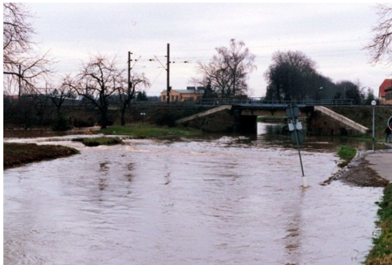
Photographie 2 : Pont SNCF sur le Canal de la Bruche à hauteur de Strasbourg (lieu-dit Holtzmatt) lors de la crue de 1990. Vue depuis l'aval rive gauche 34
