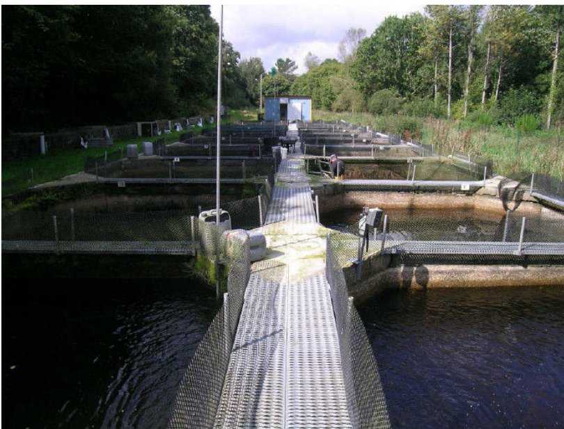
Figure 2. Bassins de la pisciculture pilote (photographie F. Simonnet).
