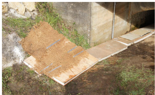
Le Ponton à Vison et à Loutre développé par le GREGE et son raccordement à la berge (à droite)
