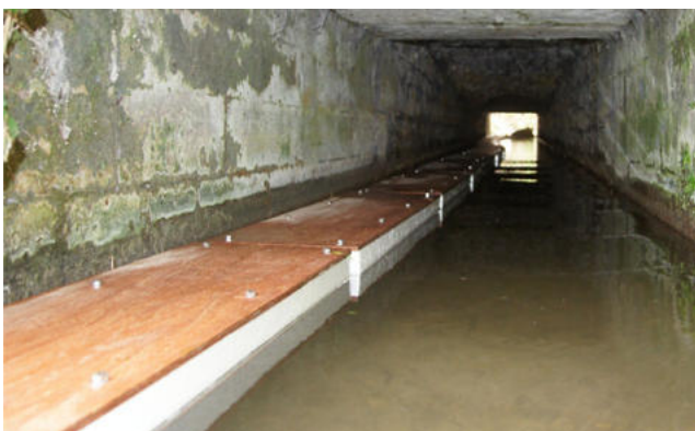
Le Ponton à Vison et à Loutre développé par le GREGE et son raccordement à la berge (à droite)
