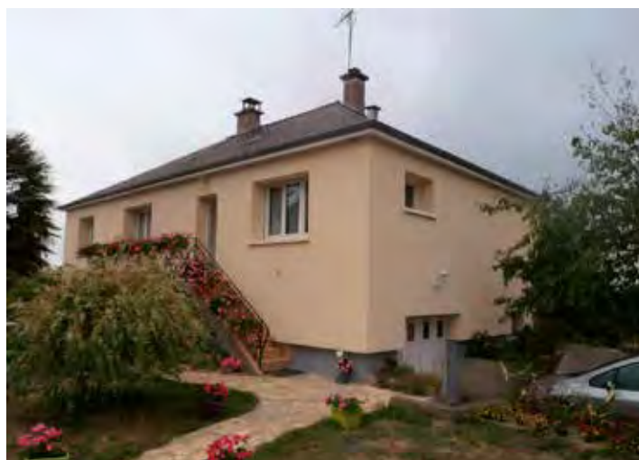
Façade après isolation thermique par l'extérieur (ITE)
