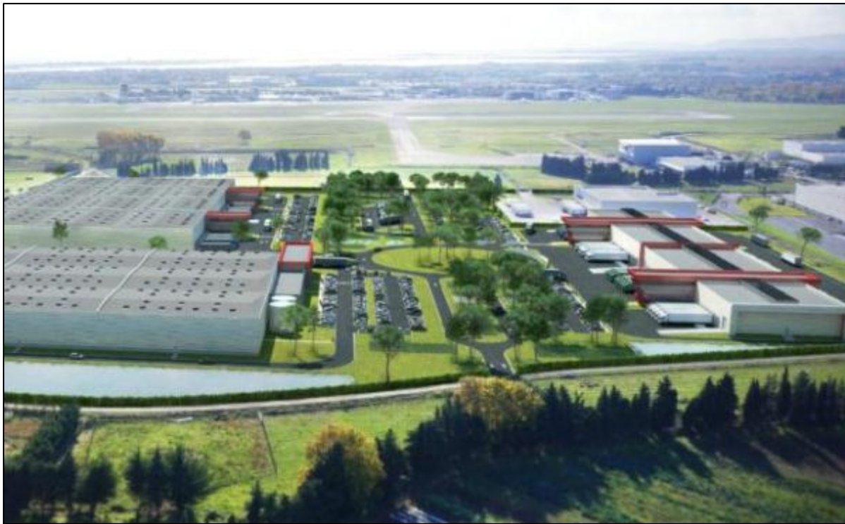
Figure 66 : Vue sur la plateforme logistique depuis le sud-ouest Source : THALIUM
