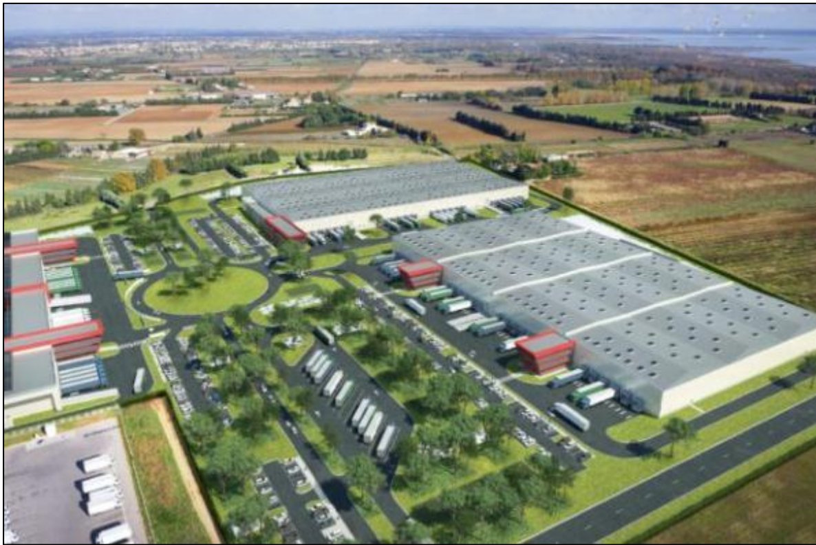
Figure 67 : Vue sur la plateforme logistique depuis le Nord-est Source : THALIUM
